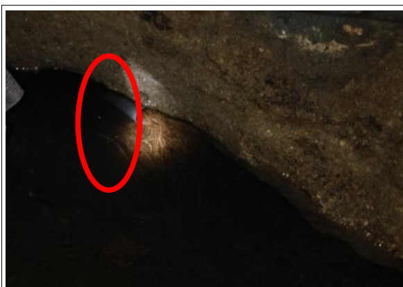
Fotografías 16. Raíces en tubo captación naciente Félix Quesada. Coordenadas E 503964 m y N 231136 m, Costa Rica Lambert Norte.
