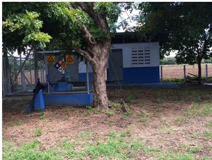
Fotografía 1: Pozo Corozal 6 (VE-105), coordenadas Lambert Norte 219080 – 409480
