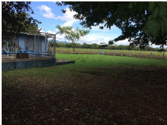
Fotografía 4: Topografía pozo Corozal 7 (94-42), coordenadas Lambert Norte 219476 - 409592
