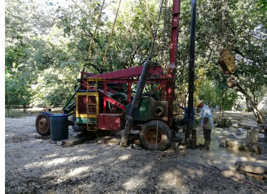
Labores de perforación mediante el método de percusión.
