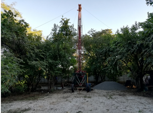
Vista de la máquina perforadora de percusión utilizada durante las labores de perforación.
