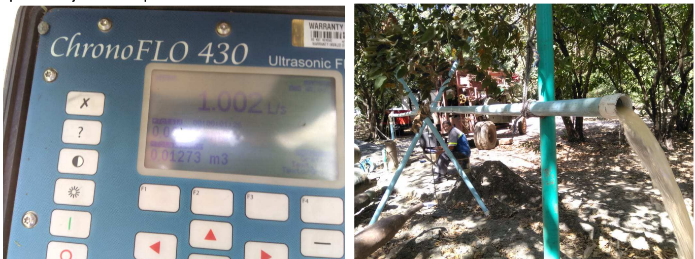
Fotografías 8-9: A la izquierda se observa el caudalímetro utilizado para la medición del caudal de extracción, a la derecha el desarrollo de la prueba de bombeo ejecutada por la UTP.
