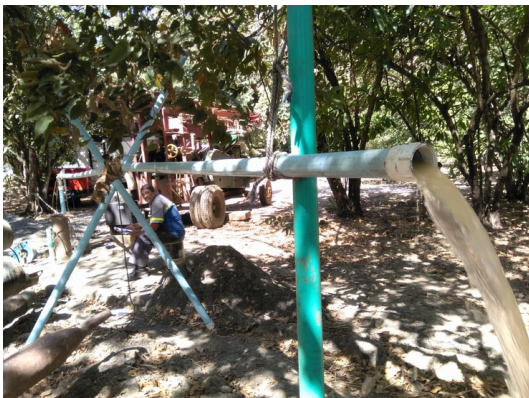
Vista de la prueba de bombeo ejecutada por la UTP. Caudal de prueba 1 L/s.
