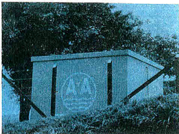
Tanque de almacenamiento de la cañería de la Mora.
