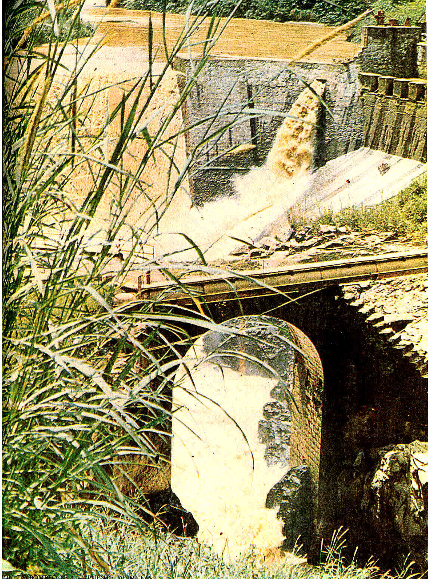
ION DE BOMBEO N.º 1 — PUENTE DE MULLAS
