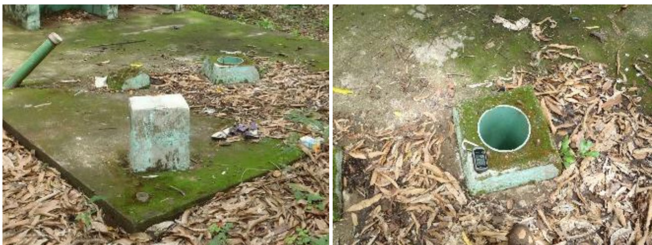
Fotografía 1. Estado actual del Pozo Saúl, 376053 E – 236303 N, Nicoya.
