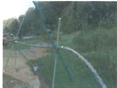
Labores de la prueba de bombeo
