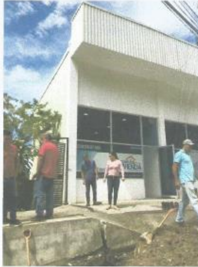
Fotografía 1. Frente del edificio y zona de fuga de agua.
