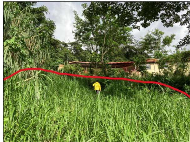
Foto 15. Escarpe principal en quebrada sin nombre. (Coordenadas 975215 N / 612900 E).
