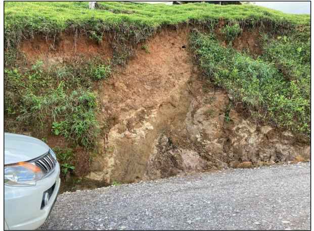
Foto 4. Suelo residual. (Coordenadas 974799 N / 613090 E).
