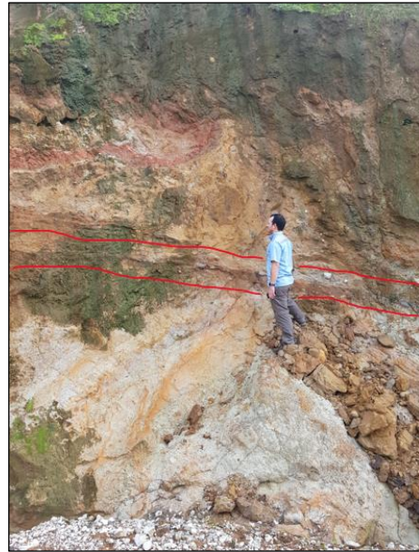
Foto 6. Contacto entre dos flujos de la unidad de Debris Flow. (Coordenadas 975306 N / 612982 E).
