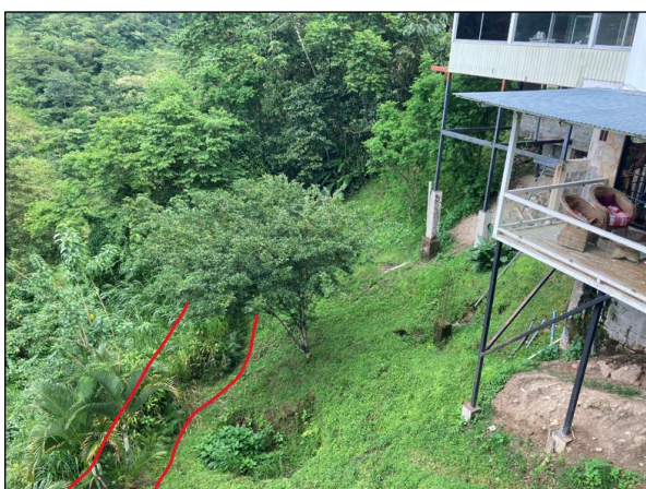
Foto 14. Escarpe de 2 m de altura. (Coordenadas 975229 N / 612900 E).
