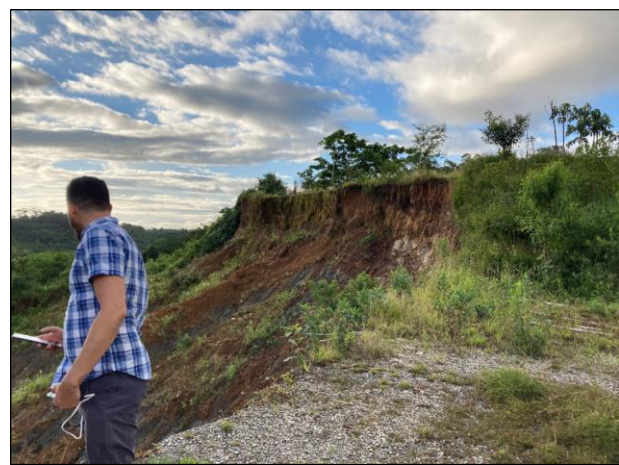
Foto 19. Escarpe de deslizamiento. (Coordenadas 974796 N / 613048 E).
