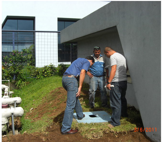
Fotografía No 6: Inspección del trabajo realizado
