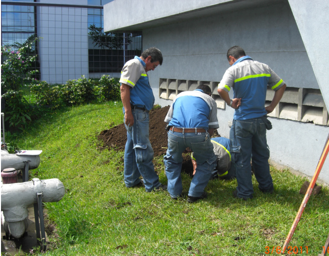
Fotografía No 3: Cuadrilla instalando el medidor principal
