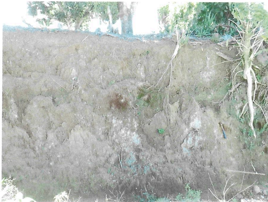
Fotografía 2: Depósitos meteorizados del Miembro Roble Alto, coordenadas 224,948 Norte y 522,195 Este, proyección Lambert Costa Rica Norte.
