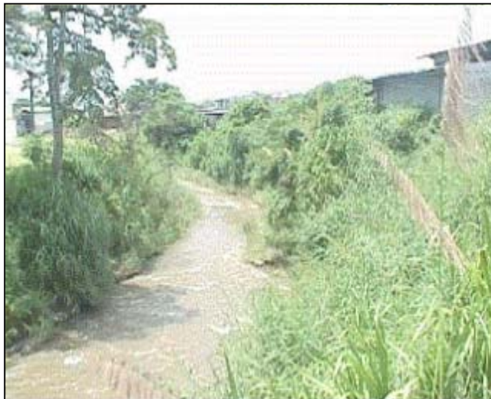
Foto 49. Zona con espacio limitado para el paso del Colector Tiribí.
