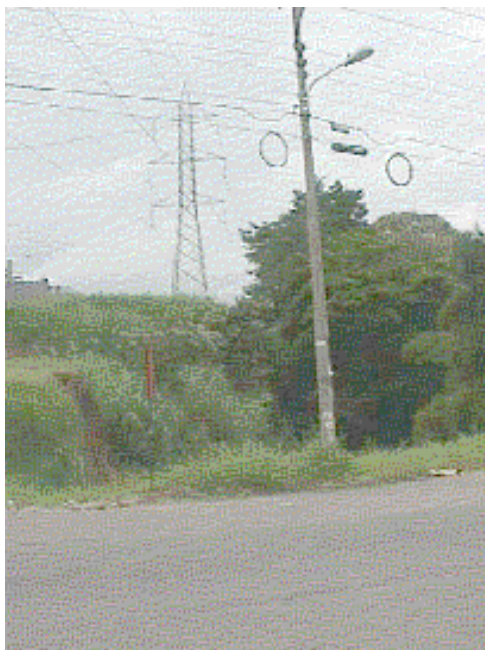
Foto 24. Zona de líneas de transmisión eléctrica del ICE por donde pasará el Colector Purral.
