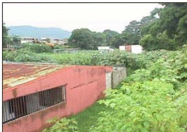
Foto 47. Zonas con espacio limitado para el paso del Colector Tiribí.
