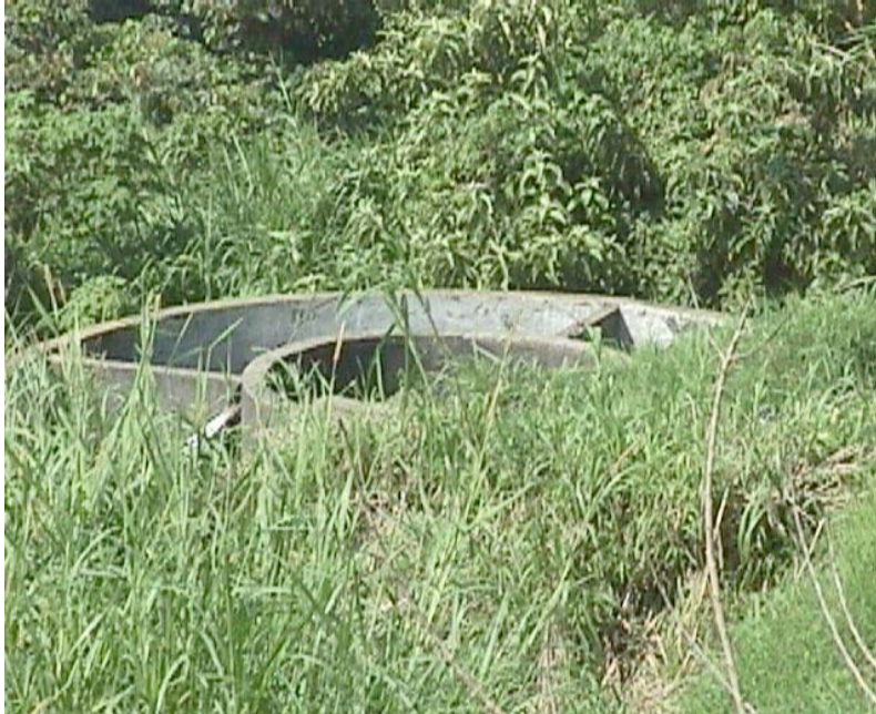
Foto 15. Planta de tratamiento de Purral actualmente sin funcionar.
