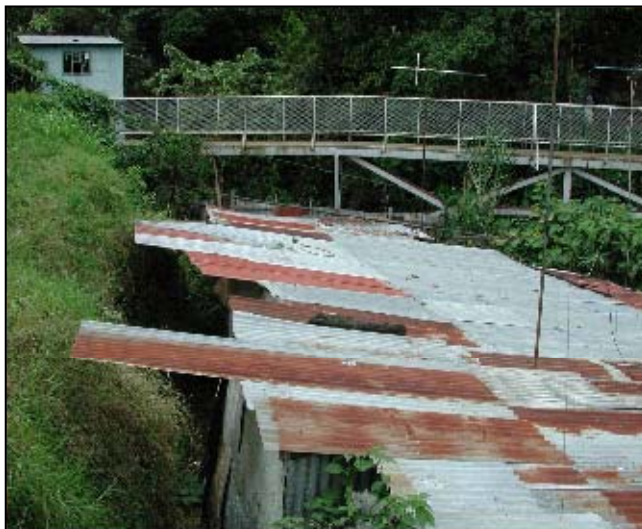
Foto 51. Presencia de casas dentro del cauce fluvial en la comunidad de Dulce Nombre.
