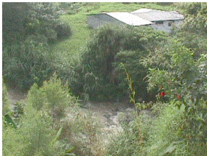
Foto 33. Vista del sector del cañón del Río Tiribí donde dará inicio el Colector Tiribí.
