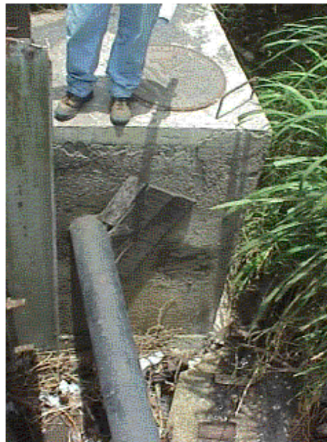
Foto 32. Vista del colector existente con el que se unirá el Colector Torres.
