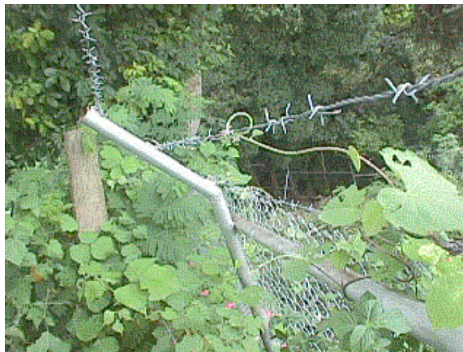
Foto 29. Vista de la malla en la Quebrada Patalillo.
