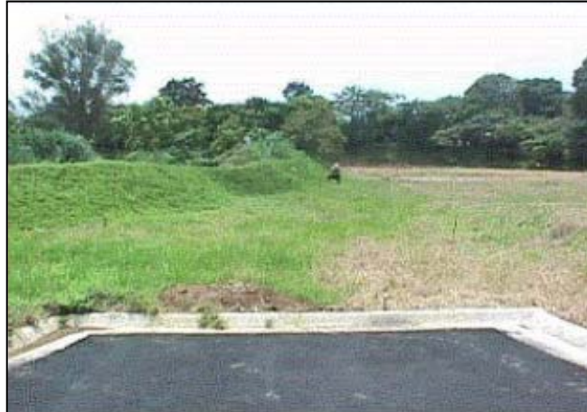
Foto 46. Diques construidos para contener el Río Tiribí.
