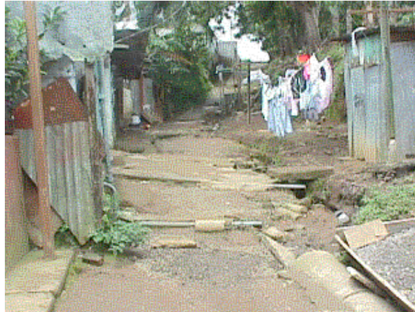
Foto 31. Vista del precario por donde pasará el Colector Torres.
