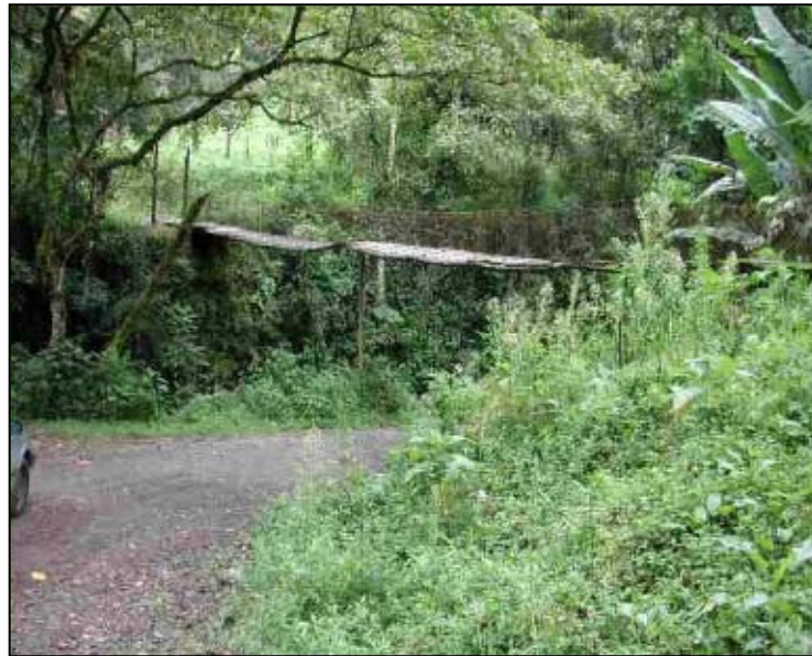
Foto 50. Puente peatonal que cruza el Río Tiribí en el inicio del colector de Tres Ríos.
