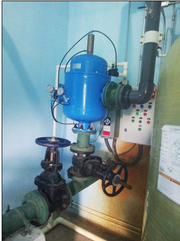
Figura 13. Filtro de malla autolimpiante.
