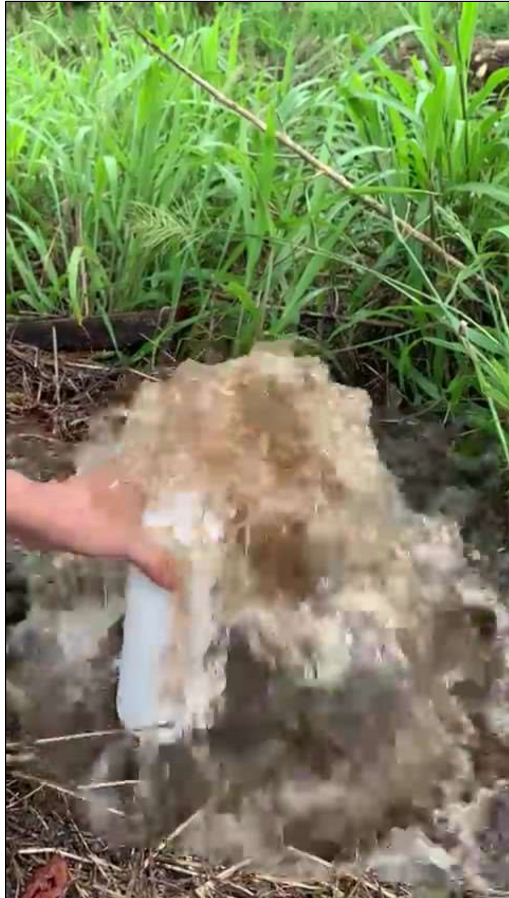
Figura 7. Agua que sale durante la purga de las tuberías.
