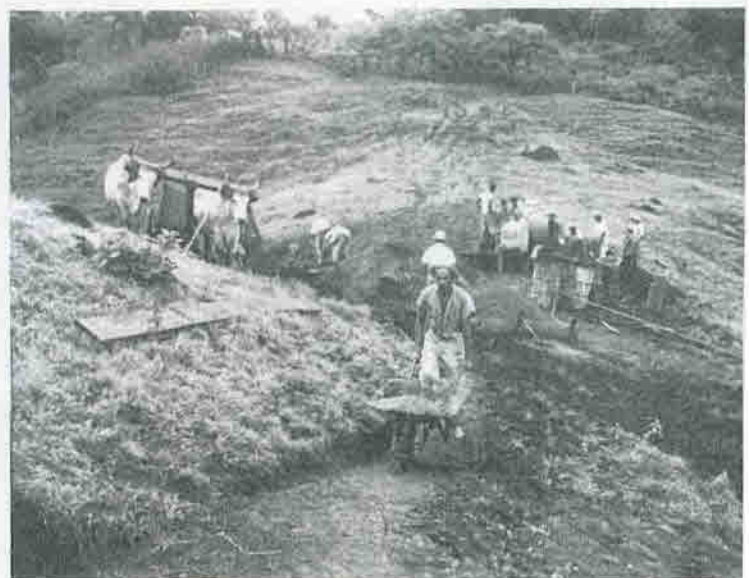
Construcción de la cañería de 27 de Abril, Santa Cruz, Guanacaste.
