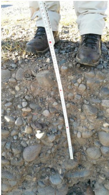
Fotografía 1. Detalle de aluviones. Coordenadas E 457368 m y N 217030 m, Costa Rica Lambert Norte.
