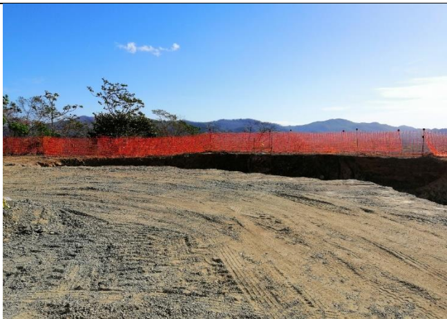
Figura 19. Zona demarcada con malla.
