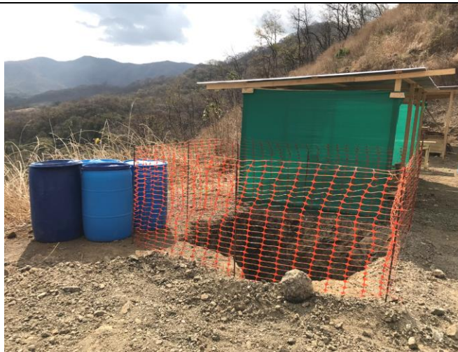
Figura 6. Construcción de fosa para capturar desechos de cemento.
