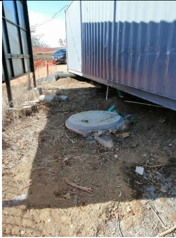
Figura 28. Tanque séptico para disposición de aguas residuales.
