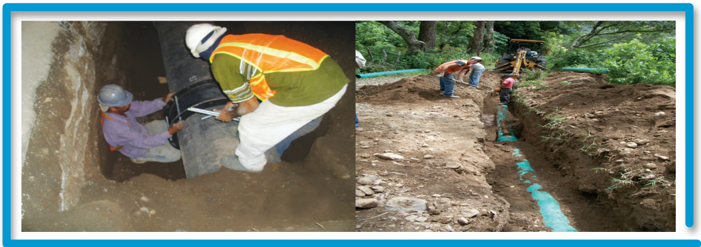
Fotografía No. 8: Sustitución de tubería
