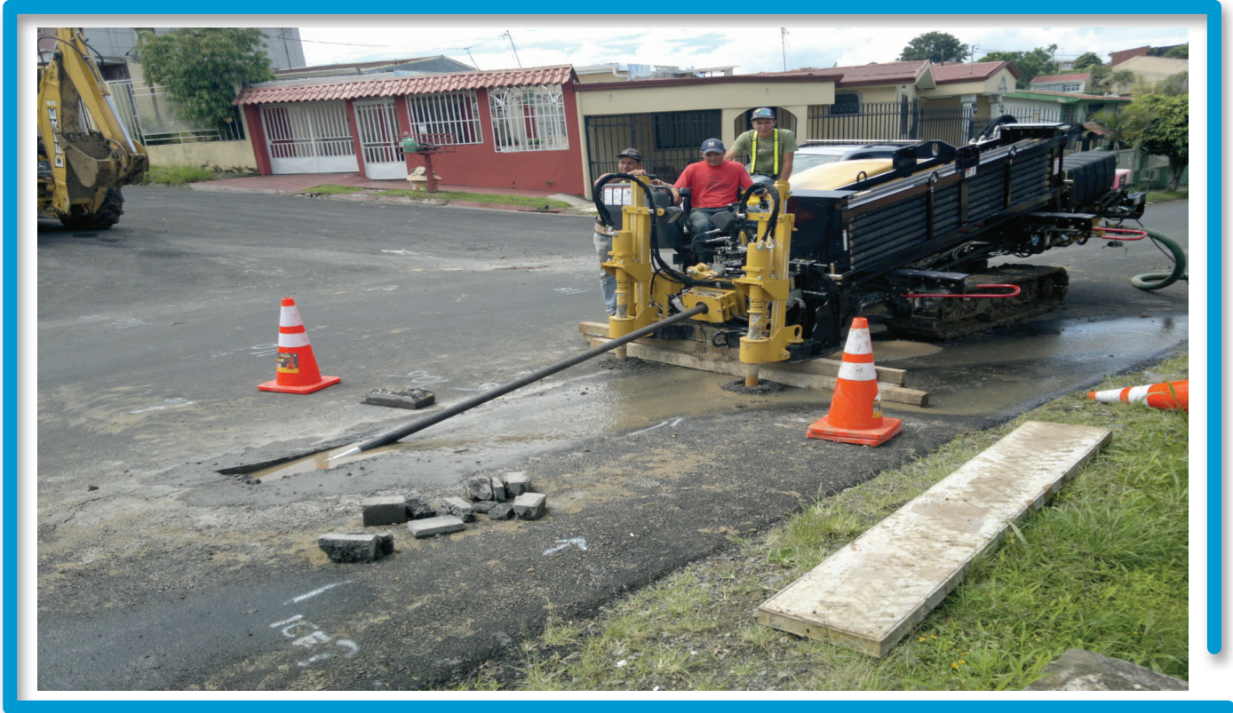
Fotografía No. 7: Sustitución de Tubería mediante Perforadora horizontal en proyecto de Cedros y San Pedro de Montes de Oca
