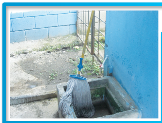
Fotografía No. 14: Pileta para limpieza de trapo piso tradicional, con llave de chorro
