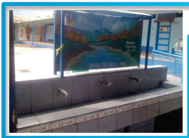
Fotografía No. 5: Válvulas temporizadas. Sustituyendo válvulas de chorro Modificación a orinal tipo "cascada" tubería de plástico multiperforada abierta permanentemente, a uno que es controlado con una válvula temporizada de botón
