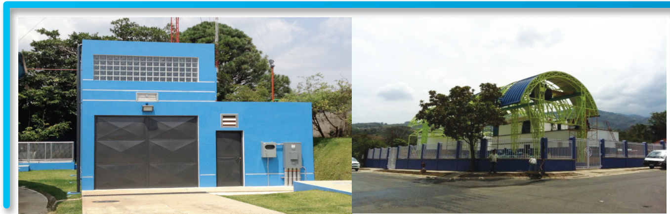
Fotografía No. 1: Estación de Bombeo del Sur
