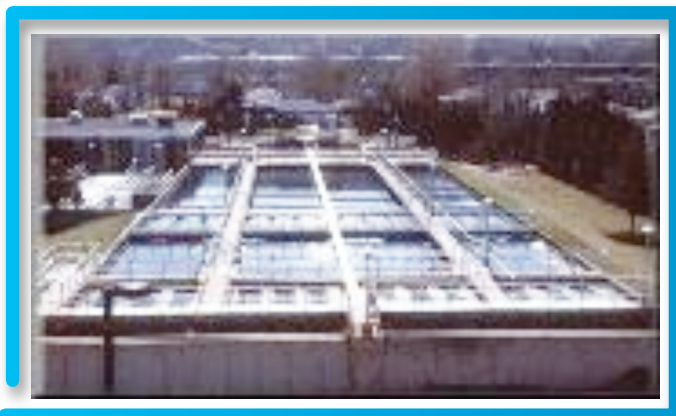
Fotografía No. 2: Batería de sedimentadores rectangulares
