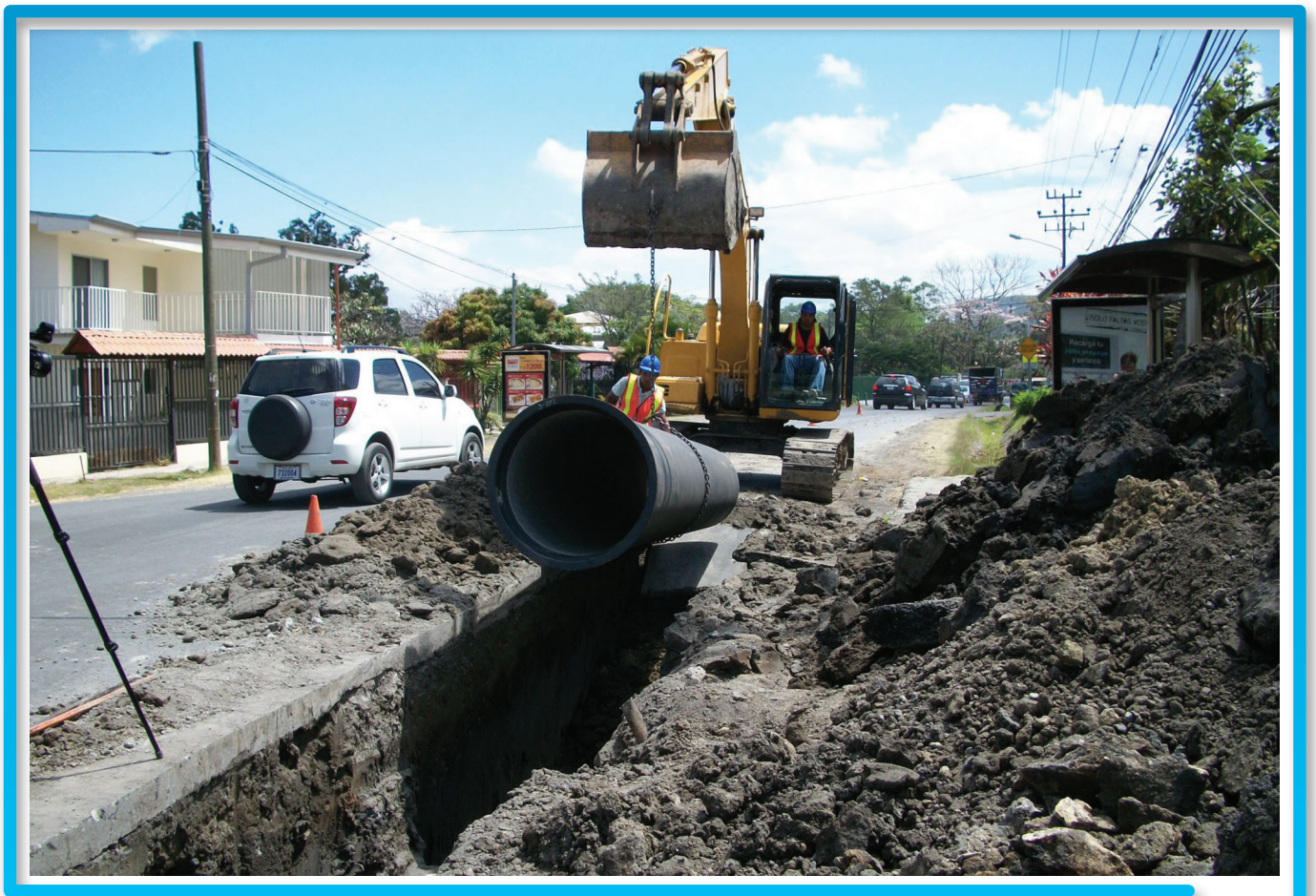
Fotografía No. 1: Colocación de tubería en Proyecto de Zona Oeste de San José
