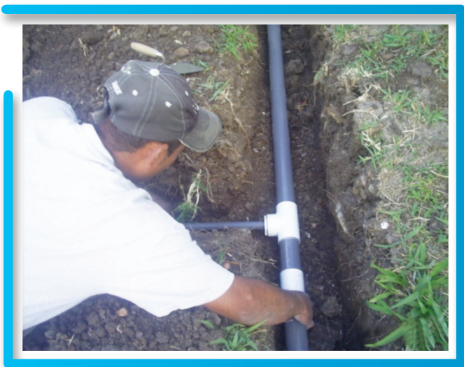
Fotografía No. 18: Instalación de una nueva red de tubería "madre" y ramales secundarios Escuela Benjamín Herrera
