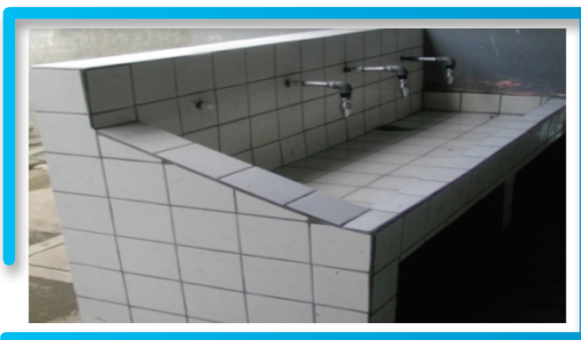
Fotografía No. 2 : Sustitución de tres llaves de chorro, por válvulas tipo fordilla en bebedero para los estudiantes
