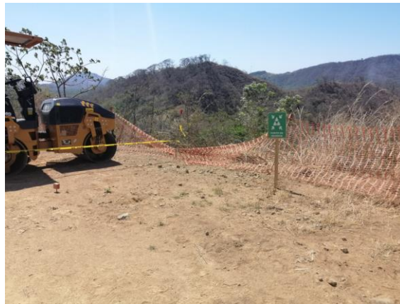
Figura 33. Rotulación dentro de la zona del proyecto.
