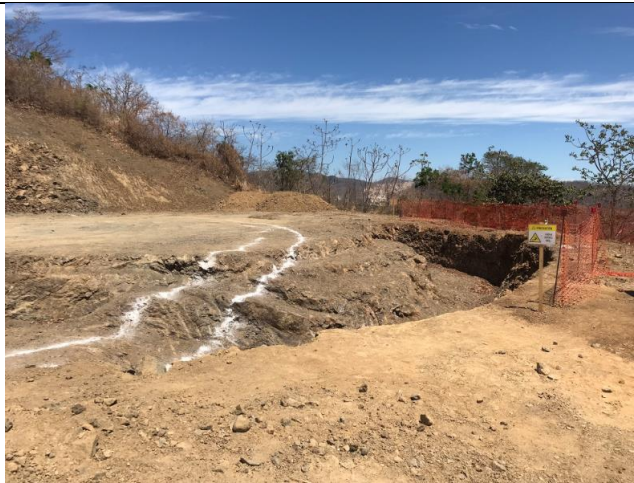
Figura 5. Excavación en el terreno del tanque de almacenamiento.
