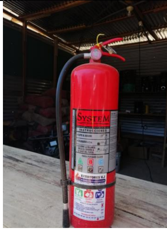
Figura 41. Extintor en el área de bodega.
