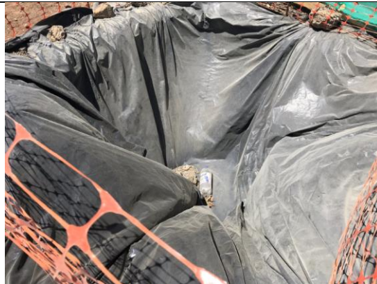
Figura 10. Fosa para capturar desechos de cemento.
