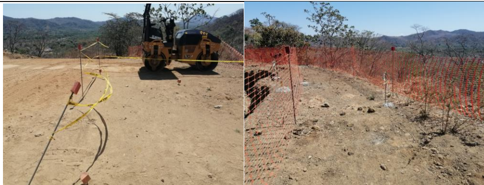
Figura 34. Demarcación de zonas con cinta.
