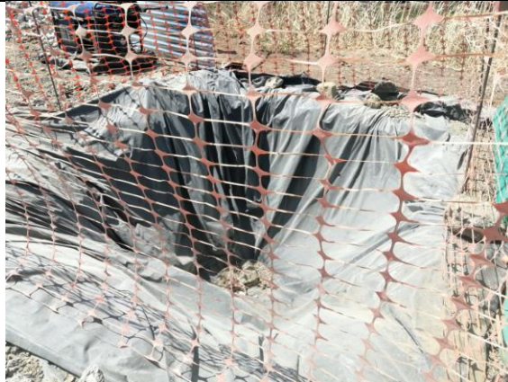
Figura 31. Fosa para depositar los residuos del lavado de maquinaria.
