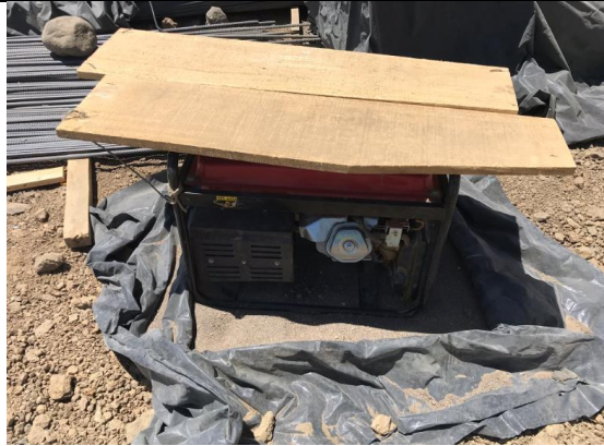
Figura 16. Protección de planta generadora en caso de derrame.
