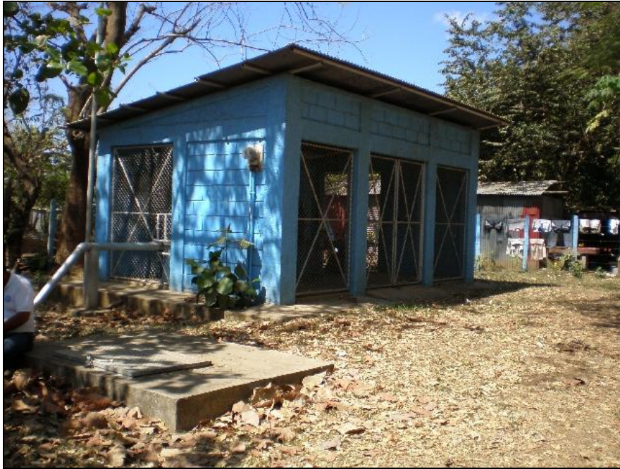
Figura 2.1. Caseta del Pozo #1 de Sardinal.
