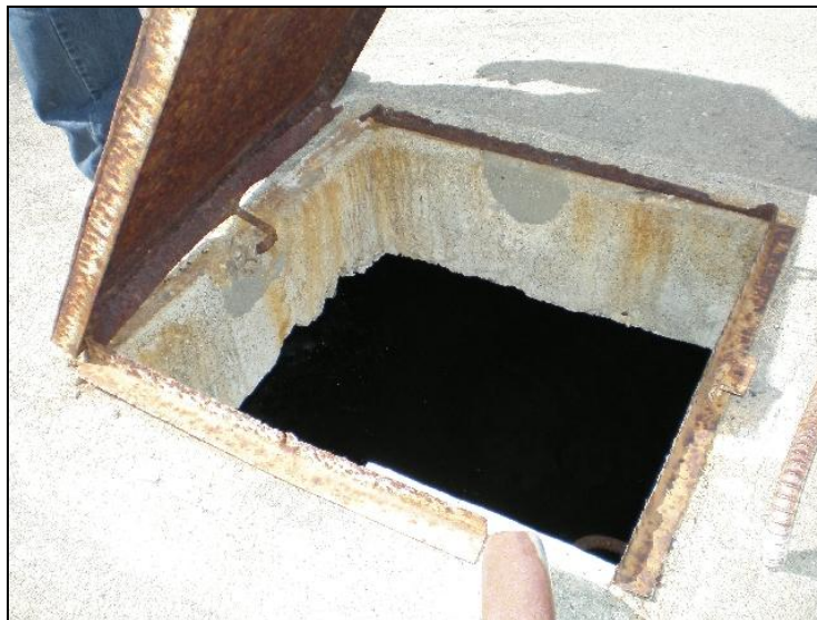
Figura 2.5. Tanque Sardinal: tapa de acceso.
