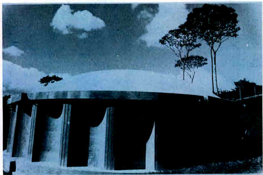
Moderno tanque nuevo acueducto de San Isidro de El General
