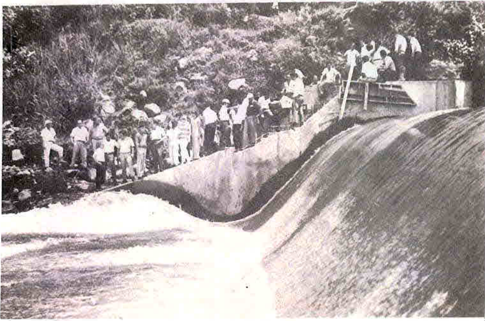
OBRA TERMINADA EN SAN ISIDRO. Las empresas contratadas por el SNA —CyP y EYLA— terminaron en el mes de junio la construcción del dique de toma de las aguas del río Quebradas, que serán destinadas, mediante el tratamiento correspondiente, al nuevo acueducto de San Isidro de El General.
