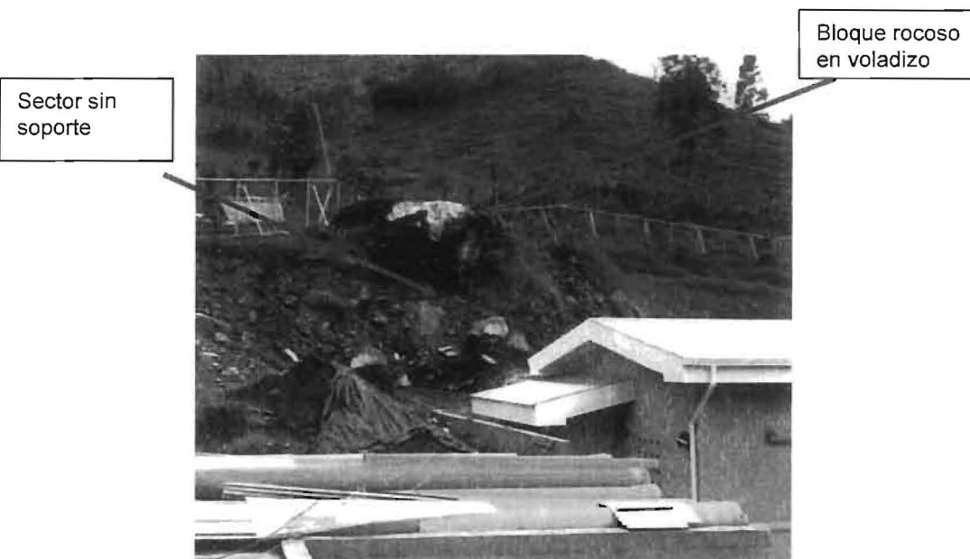
Figura No 1. Bloque de roca en voladizo sin soporte frontal
