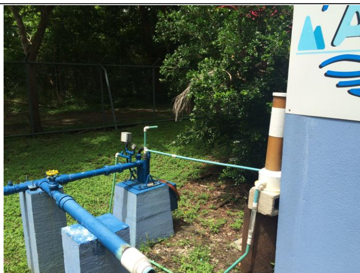
Fotografía 1: Pozo Tambor (Coordenadas 423800-187700, Lambert Norte)
