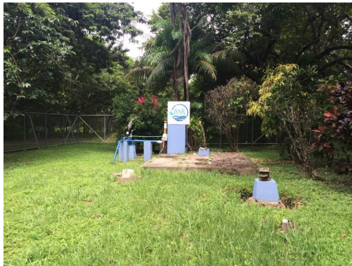
Fotografía 5: Estado actual pozo Tambor 01-13 (coordenadas 423800 - 187700, Lambert Norte)
