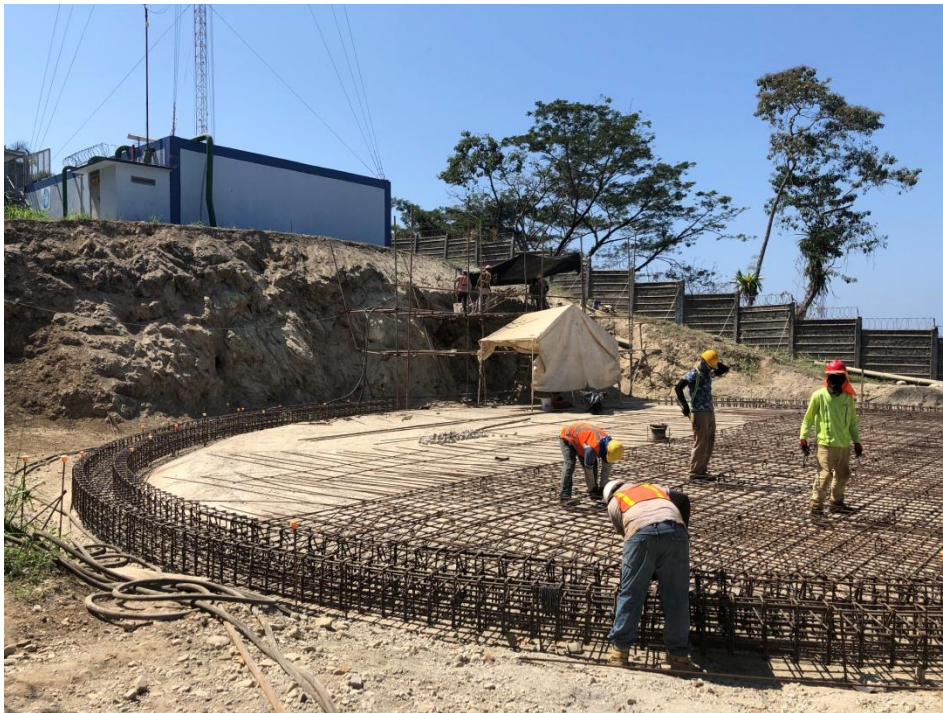
Foto 1 inicio excavación y relleno tanque de Quepos.
