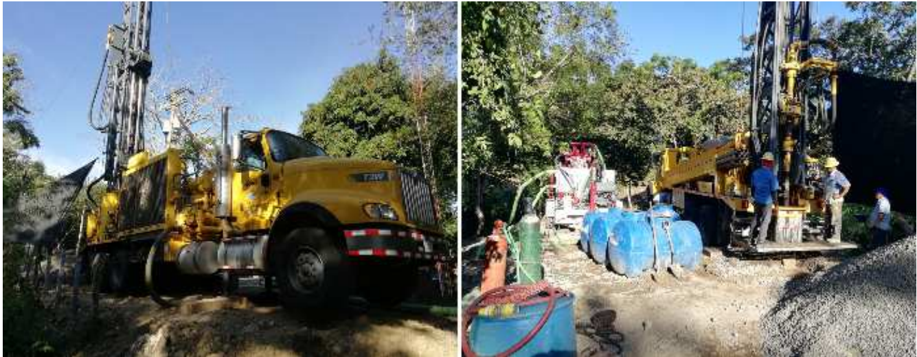
Figura 3: Fotografías de las actividades de perforación y la prueba de bombeo del pozo construido.
