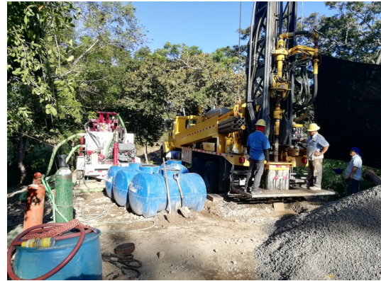
Labores de perforación mediante el método de rotación con recirculación de lodos.
