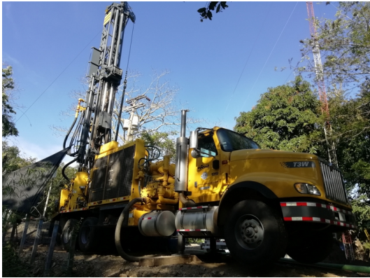
Máquina de perforación T3W utilizada durante las labores de perforación.
