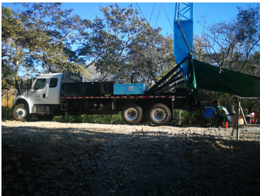
Labores de la prueba de bombeo a caudal constante.
