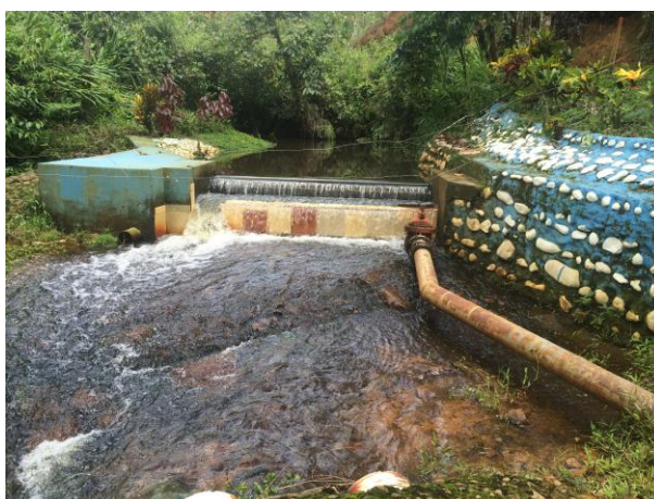
Fotografía 2: Vista frontal de sitio Toma Claudio Vargas (Coord. 134857-569882 Lambert Norte).
