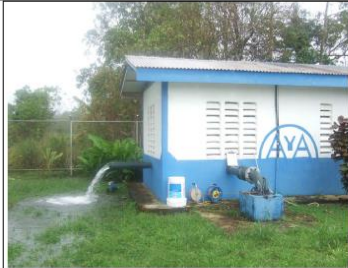
Foto 1: prueba de bombeo en pozo
