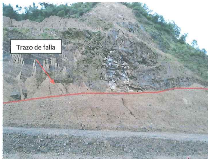
Fotografía 8 Trazo de falla cortando las rocas de la Formación Pacacua (187,456 Norte y 525,096 Este, proyección Lambert Costa Rica Norte).
