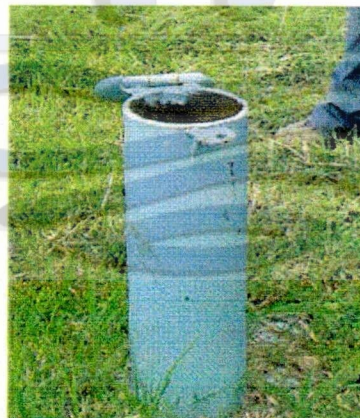
FOTO 11: Se puede observar el acabado en este pozo. Tanto el sello de concreto en la base, como la tapa en la parte superior del tubo sirven de protección al acuífero. GEOASTEC®Barreal, julio de 2005
