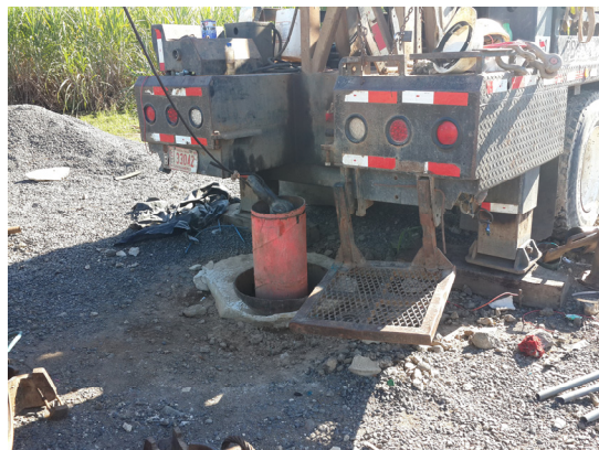
Fotografía 4. Pozo CN-726 (Trancas N° 2) 361756 E – 285255 N. Margen este de carretera.
