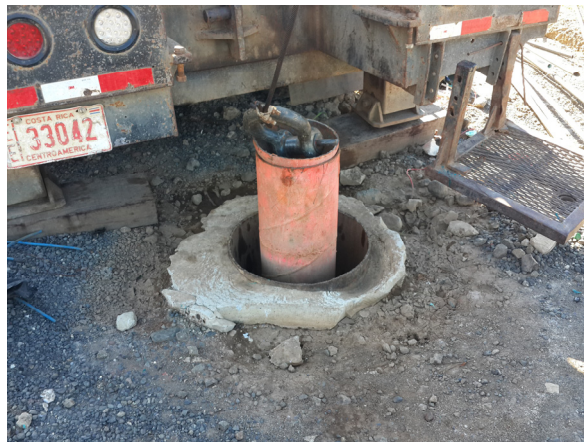
Fotografía 3. Pozo CN-726 (Trancas N° 2) 361756 E – 285255 N. Margen este de carretera.
