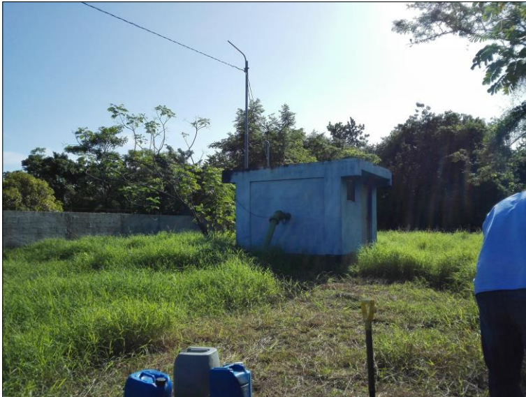
Fotografía 4: Pozo ILG-957 (L4), coordenadas 261117 N y 350602 E.
