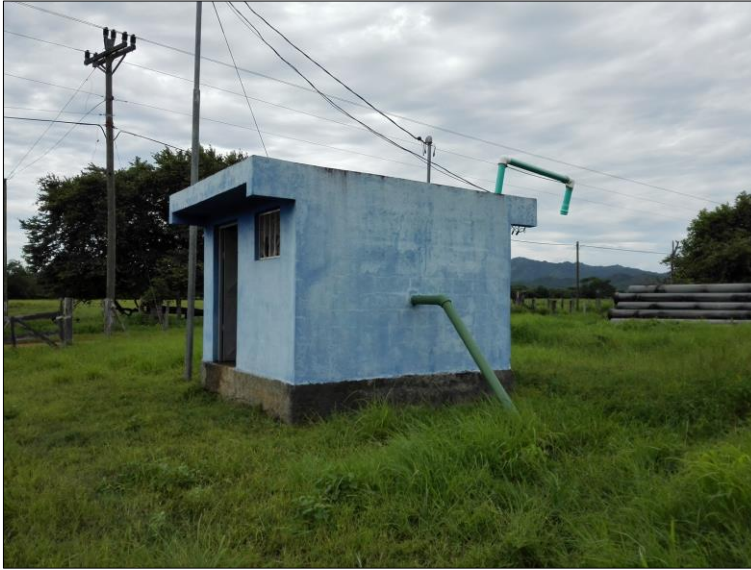
Fotografía 1: Pozo BE – 359 (L1), coordenadas 261180 N y 350381 E.
