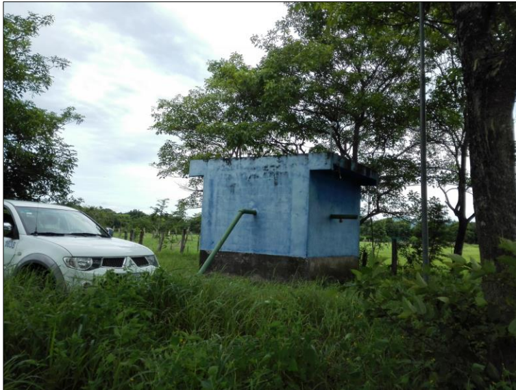
Fotografía 2: Pozo BE-368 (L2), coordenadas 261026 N y 350368 E.
