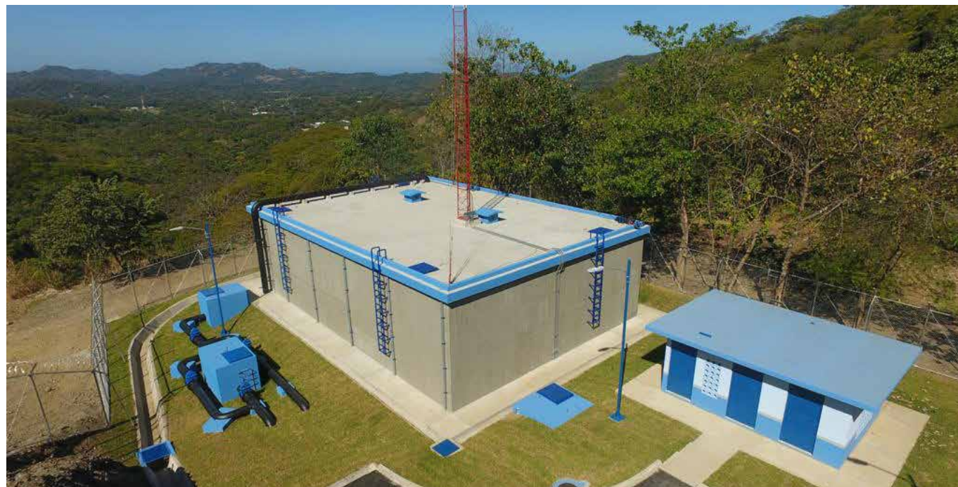
Tanque de Huacas
