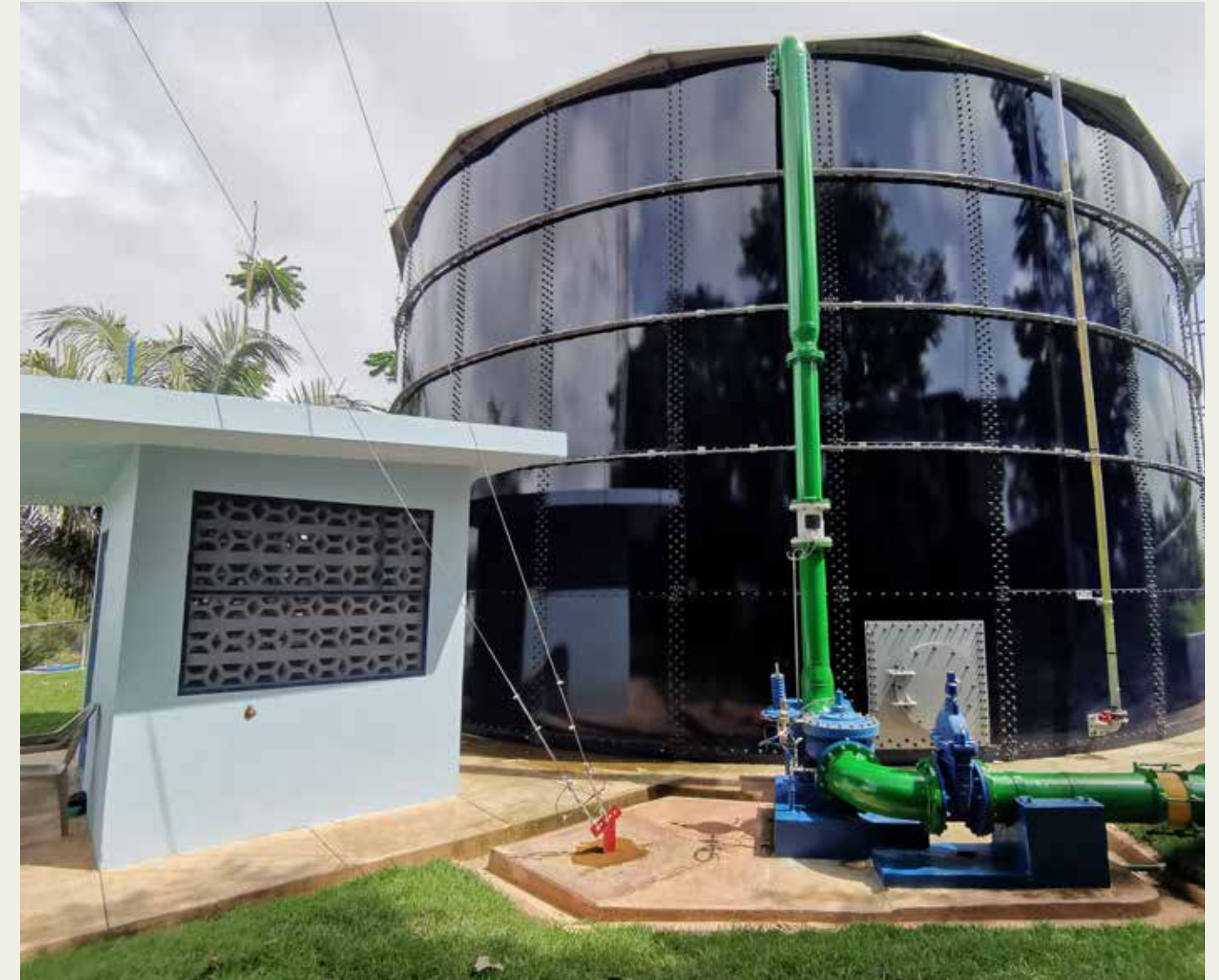
Tanque de Quepos
