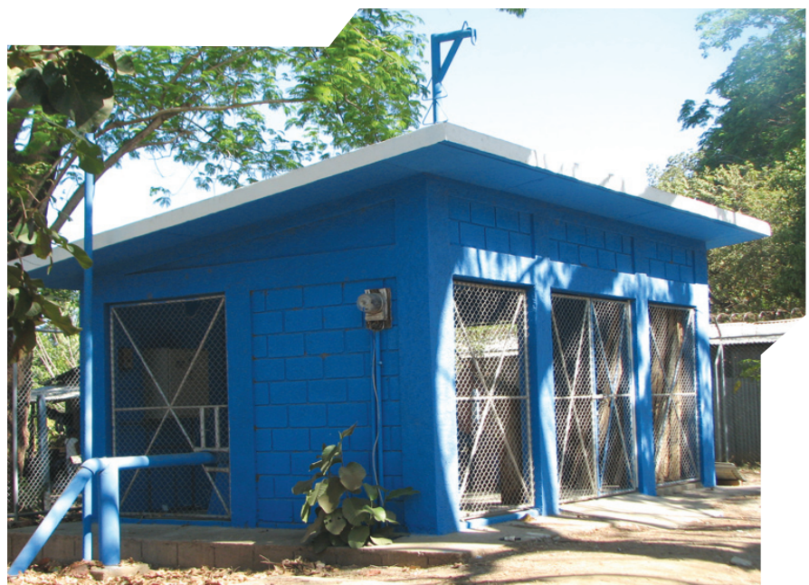
Caseta de bombeo en la Región Chorotega
