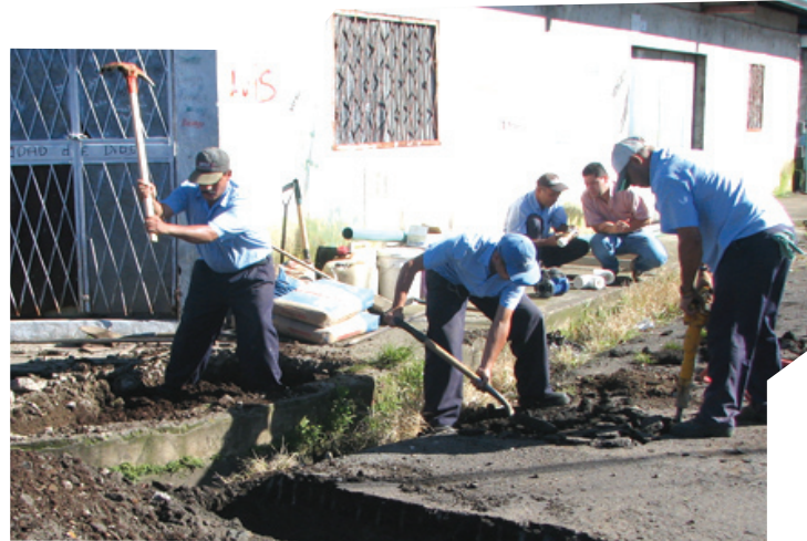
Funcionarios de AyA laboran para concluir proyectos de agua
