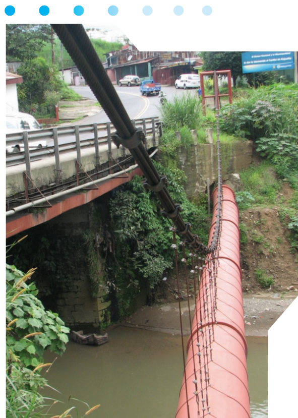
Cambio de Tubería de Aguas Residuales en Alajuelita
