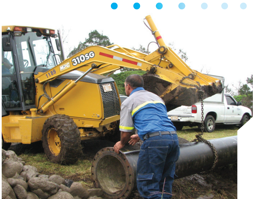
Cuadrillas de AyA en procesos de Reparación
