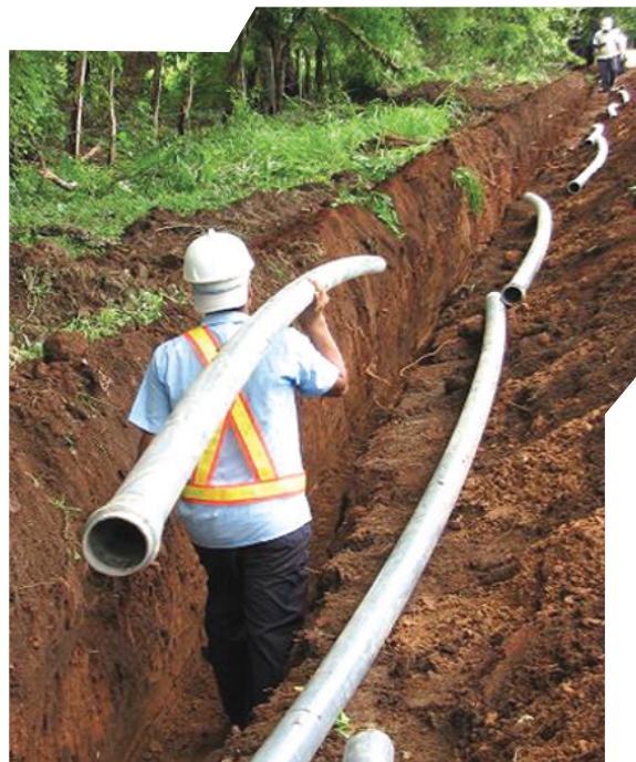
Funcionarios de AyA sustituyen tuberías de agua potable
