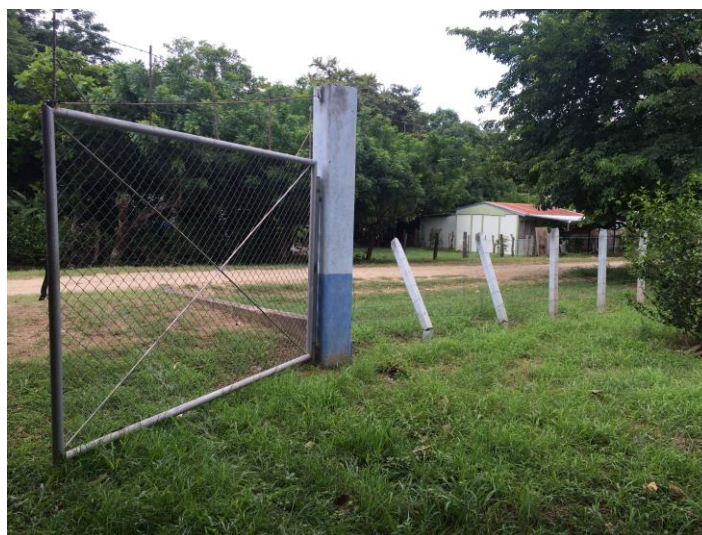
Fotografía 5: Entrada de acceso a pozo Tempate, (coordenadas 266220 latitud – 348160 longitud, Lambert Norte)
