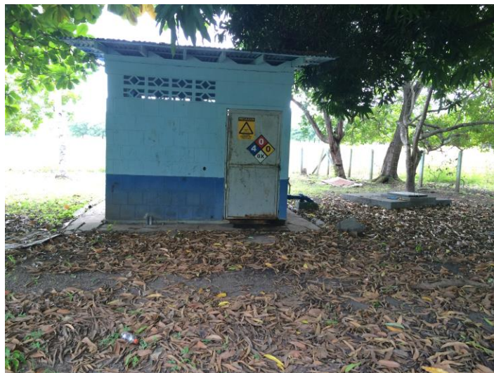
Fotografía 1: Pozo Tempate, BE-385 (coordenadas 266212 N – 348165 Este, Lambert Norte)
