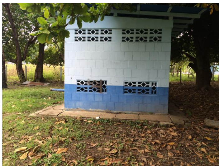
Fotografía 2: Pozo Tempate, BE-385 (coordenadas 266212 N – 348165 Este, Lambert Norte)
