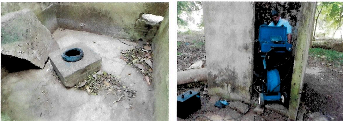
Fotografías 1-2: A la izquierda se muestra el estado del pozo al momento de la visita de campo, a la derecha el equipo de filmación perteneciente a la UTP.
