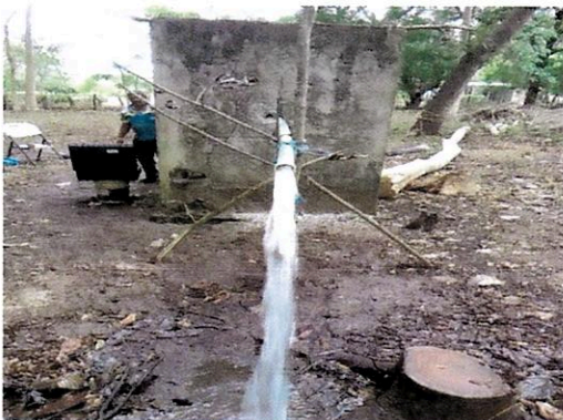
Prueba de bombeo realizada por la UTP. Caudal de extracción 7,4 L/s.
