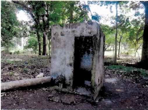
Estado del pozo Barbudal al momento de la visita efectuada el día 9-12-2019.
