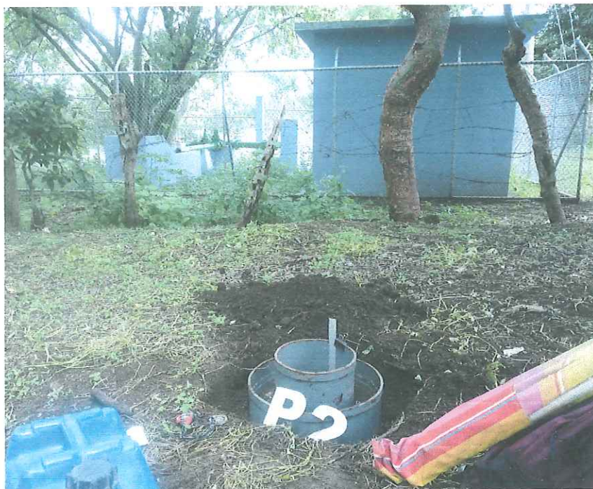
Fotografía 4: Prueba de infiltración (P-2), coordenadas 515459 E/220052 N
