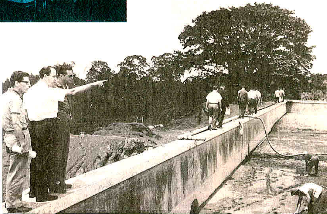
En visita de algunos señores diputados a las plantas de Tres Ríos, el Ing. Guillermo Roviralta, Jefe del Depto. de Estudios Básicos, explica el proceso de limpieza de uno de los filtros lentos.
