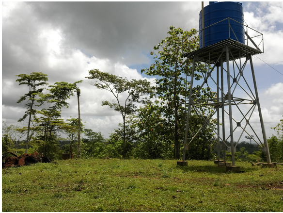
Sitio tanque (se ubica en una loma), vista Suroeste
