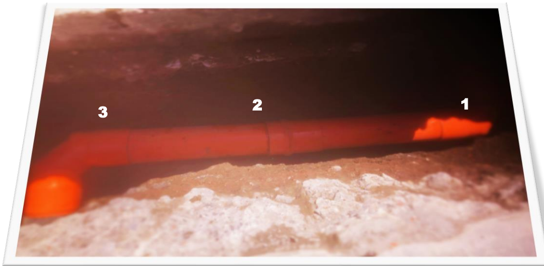
Ilustración 4 Instalación con cabos.
