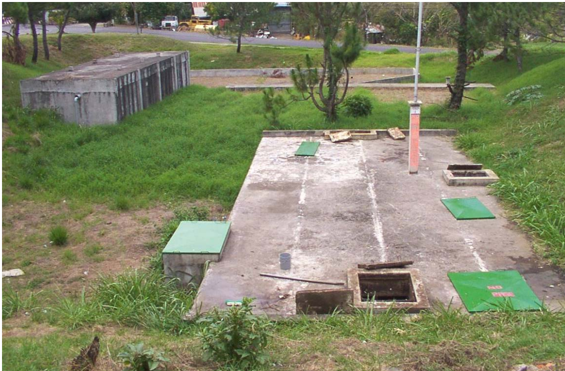
Estructuras de la PTAR La Giralda
