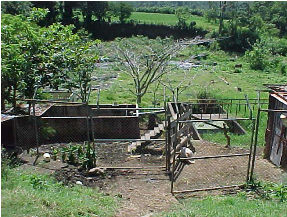
Vista general de la PTAR Carmen Lyra
