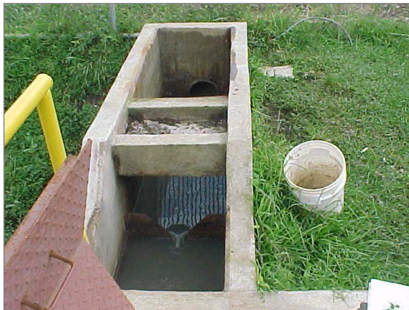
Cámara de entrada y rejillas
