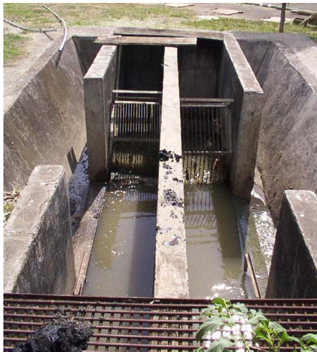
Cámara de entrada con las rejillas para retención de flotantes. A la derecha la salida del caudal de excedencias.
