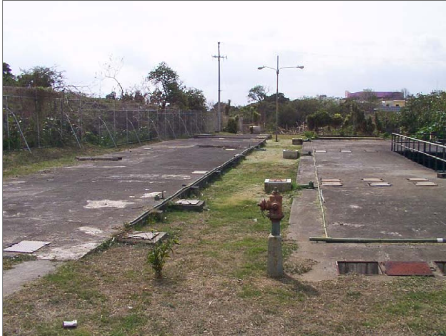
Vista general de la planta de tratamiento. A la derecha el sedimentador y a la izquierda el tanque de aireación y el sedimentador secundario
