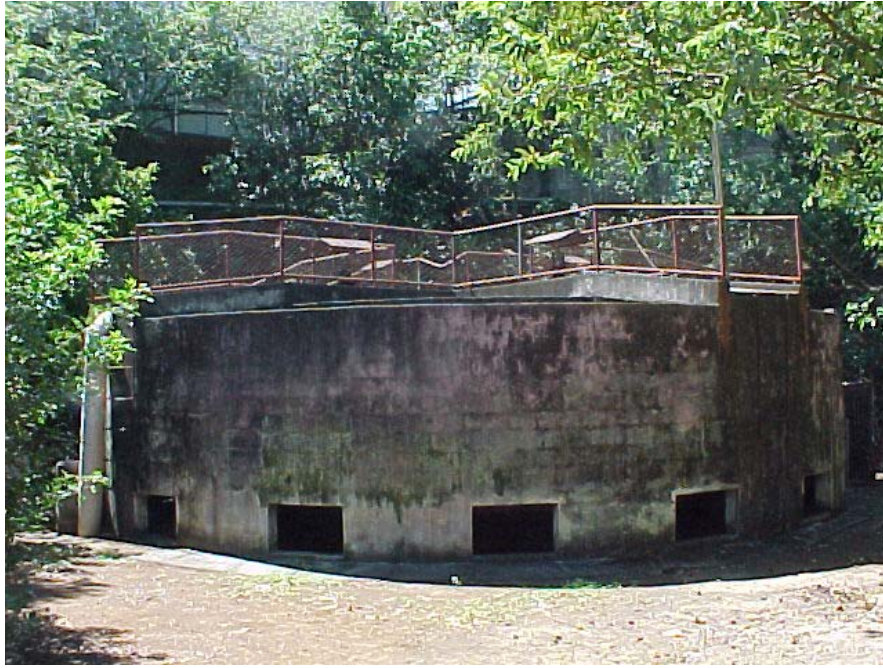
Tanque de aireación mecánica + filtro aeróbico
