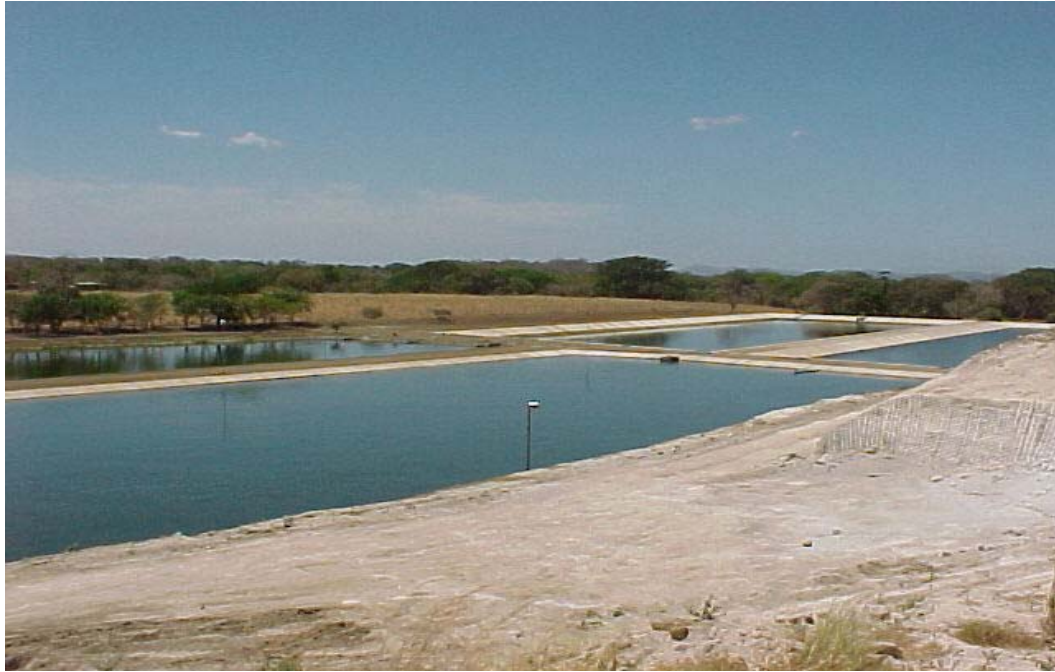
A la derecha se observan las lagunas facultativas primarias y a la izquierda las lagunas facultativas secundarias.
