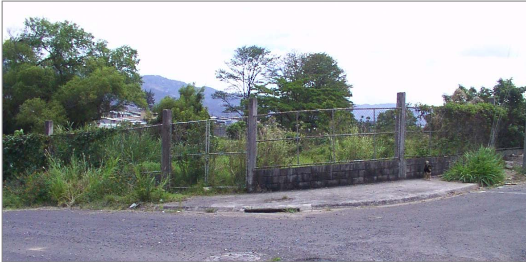
Entrada Principal a la PTAR Ciudad de Oro
