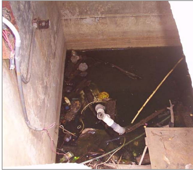
Interior de uno de los Tanques
