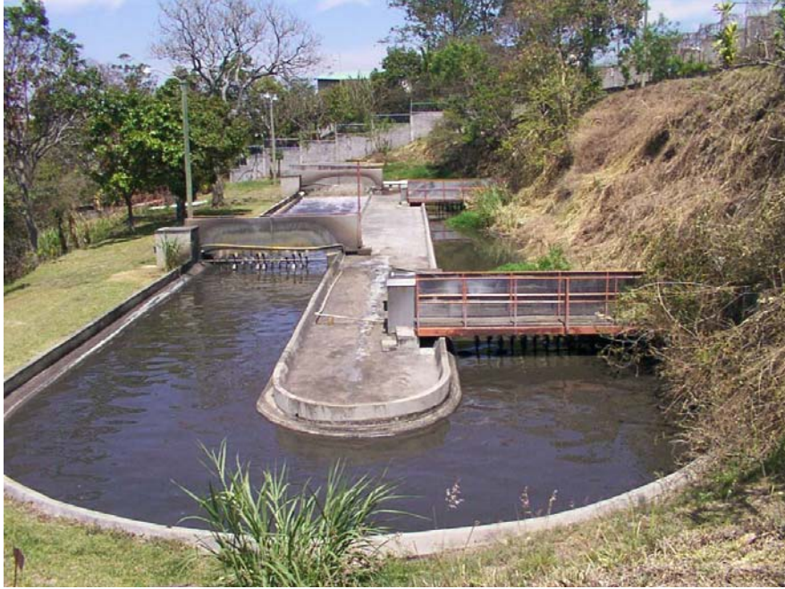
Canales de oxidación
