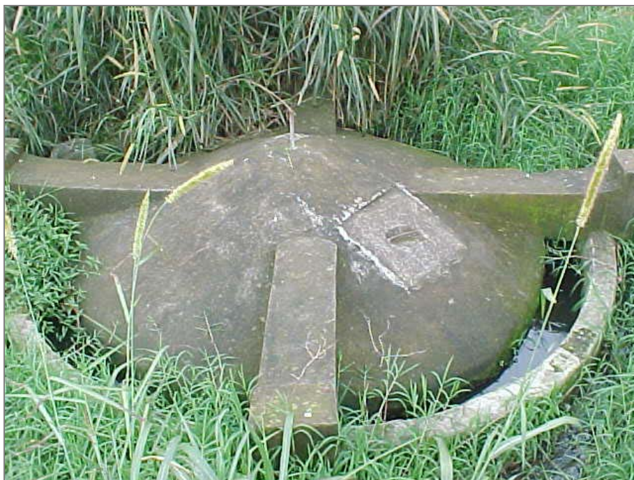
Estructura del UASB
