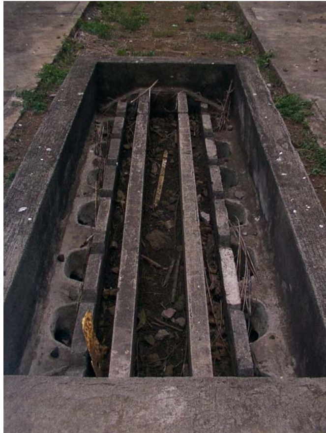
Cámara de distribución de caudales
