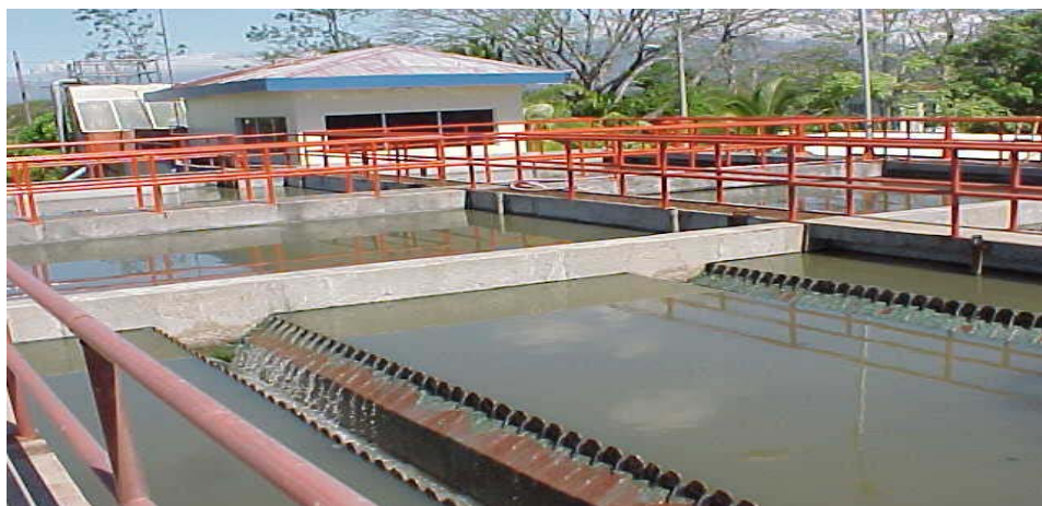
Sedimentadores primarios
