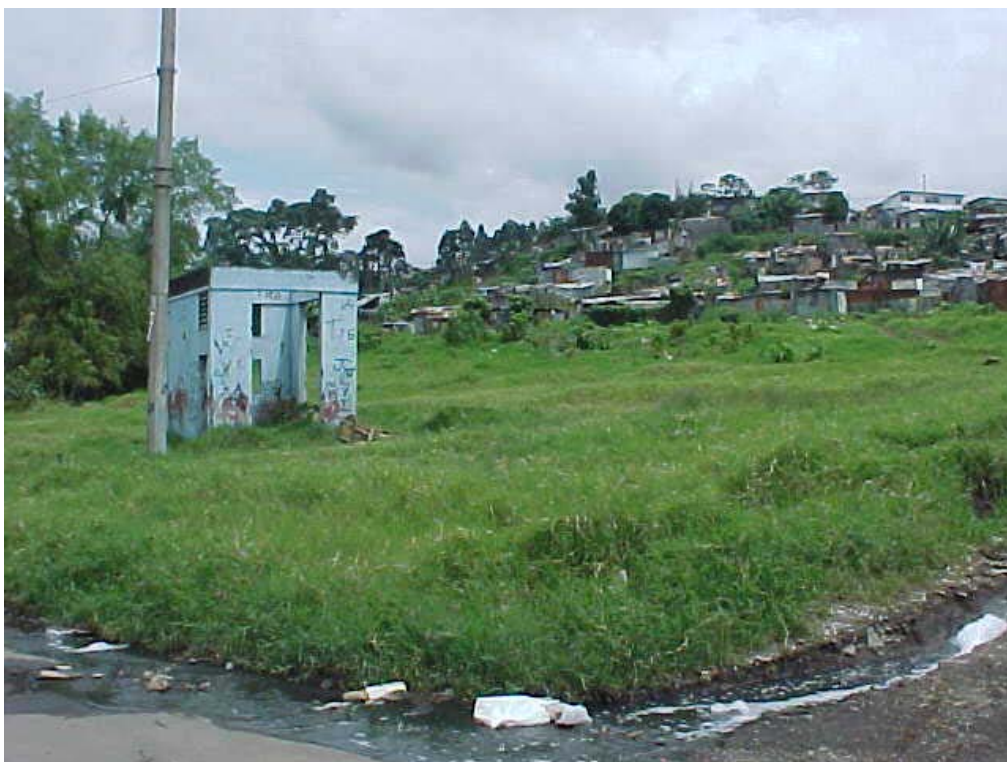
Esta es una de las estaciones de bombeo que se construyeron y que nunca fueron utilizadas
