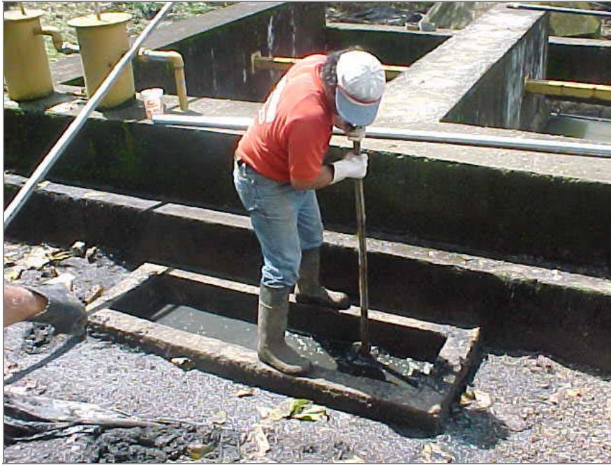
Desobstrucción de la Caja Distribuidora de Caudales
