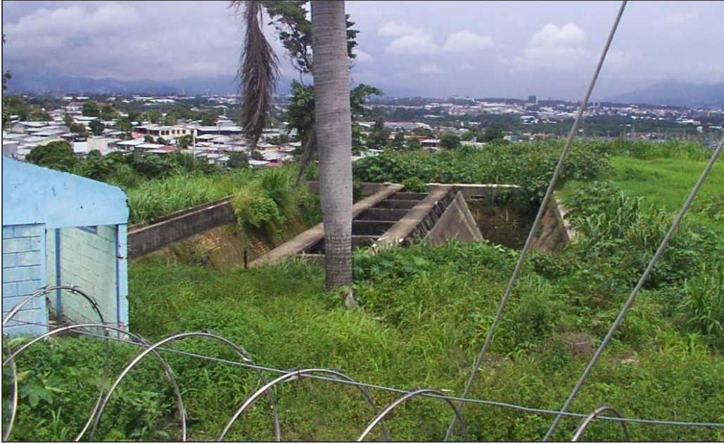
Vista General de la PTAR de la Ciudad de Heredia
