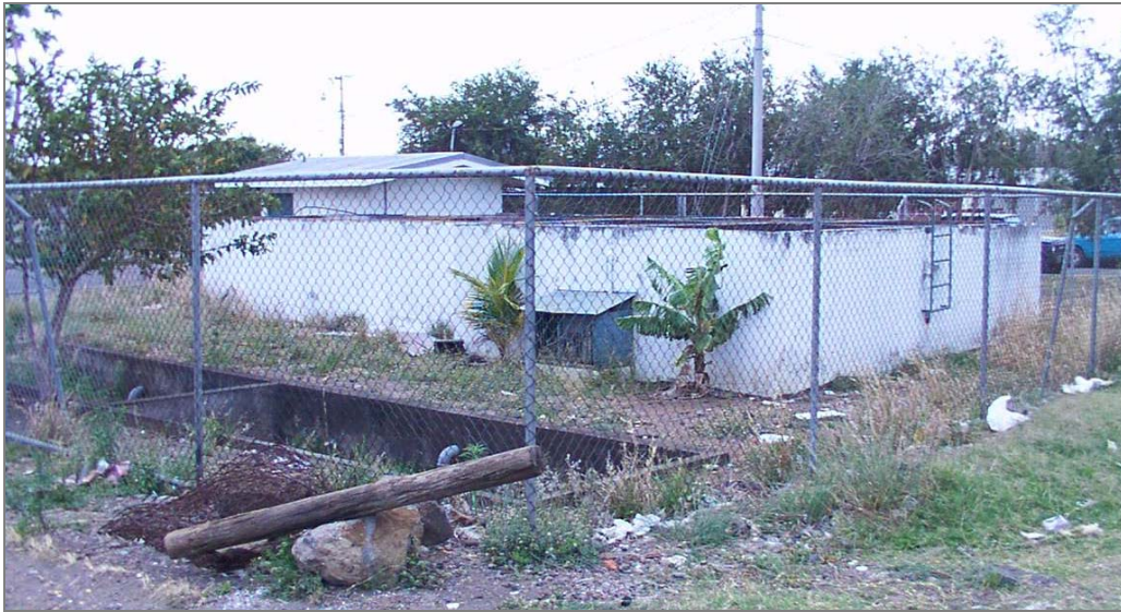
Vista de la PTAR La Lucha
