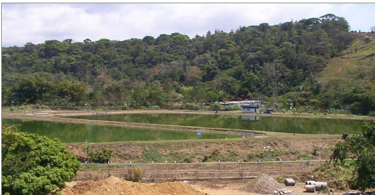
Lagunas de Estabilización Facultativas de San Isidro de Pérez Zeledón
