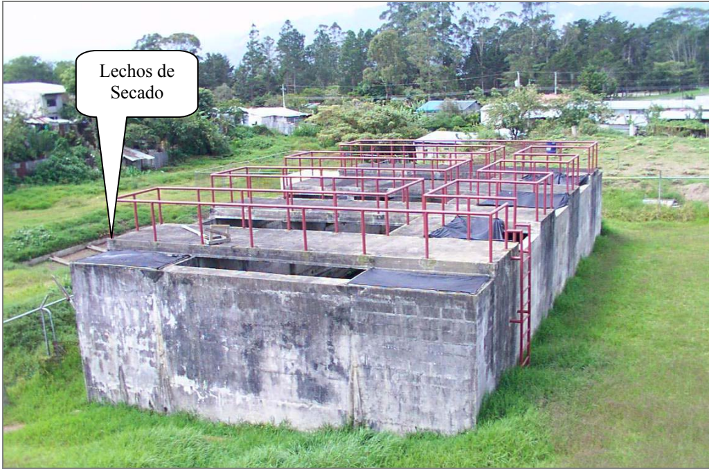
Biodigestor y Lechos Secado
