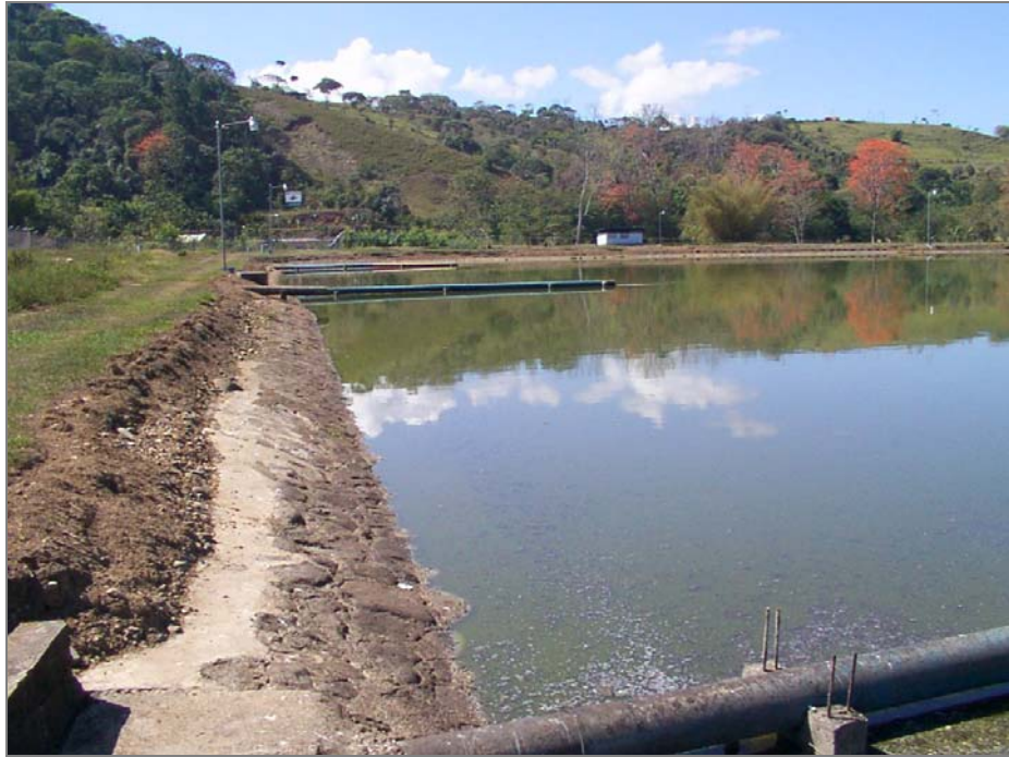
Talud y Estructuras de Entrada de la Laguna 2
