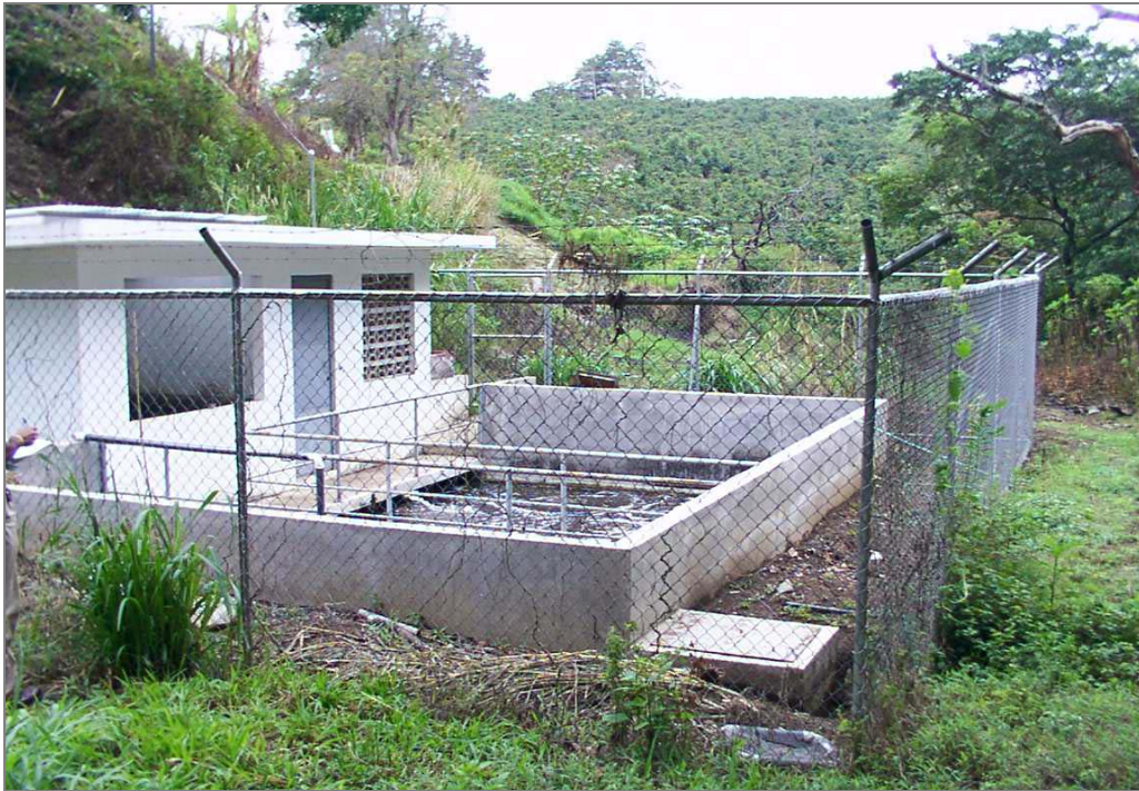
Vista General de la PTAR Nazareth
