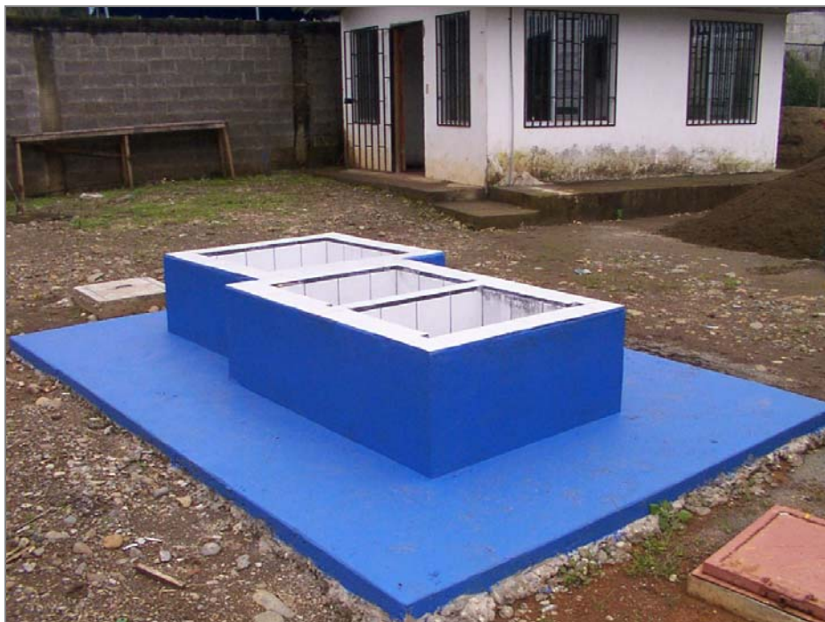
Vertedero de Excedencias y Estructura de Entrada y Rejillas
