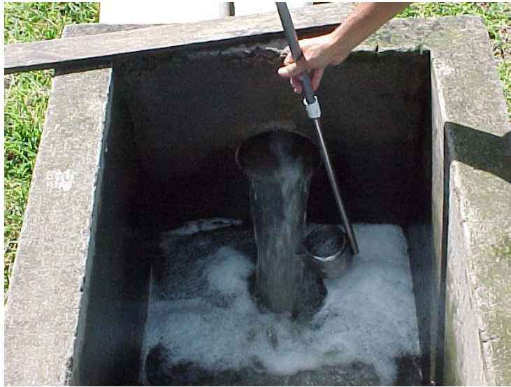
Toma de muestra de agua residual cruda Cámara de rejillas (1 er muestreo)
