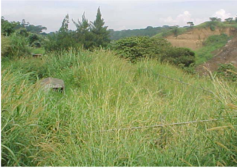
La PTAR esta cubierta totalmente de maleza
