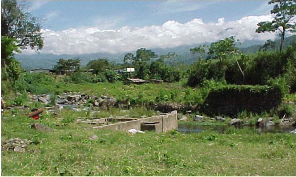
Estructuras de la PTAR que han sido arrastradas por crecidas del Río AQUIARES
