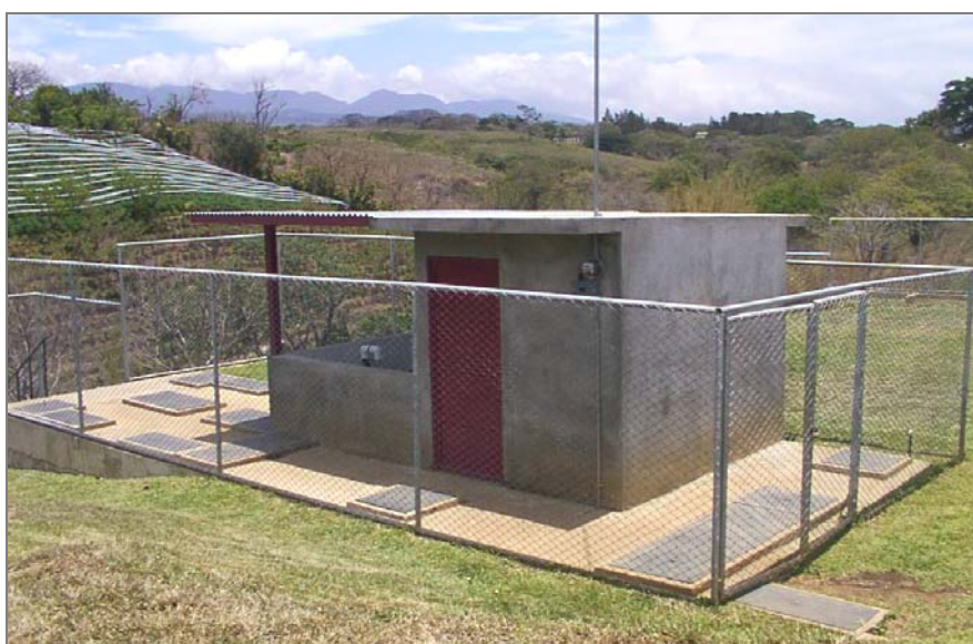
PTAR Real de Santamaría Oeste
