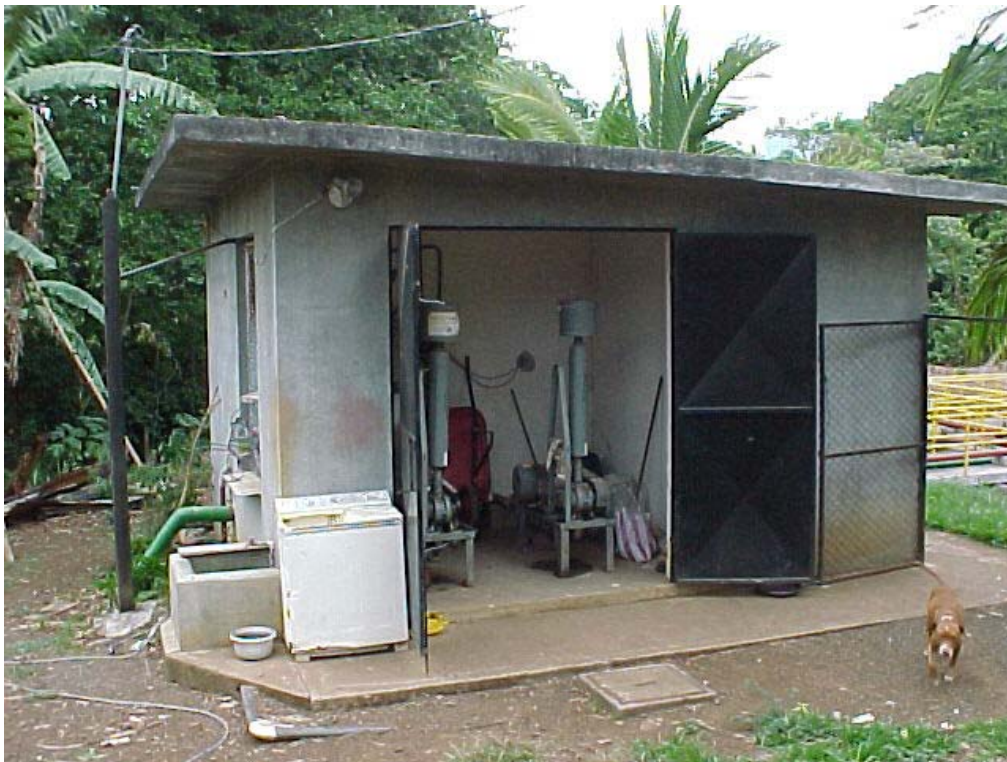
Caseta de sopladores
