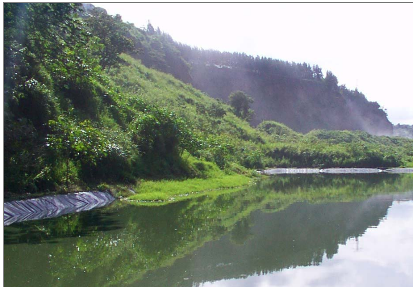
Talud norte por donde posiblemente ingresa agua de lluvia a la laguna (1 er muestreo)
