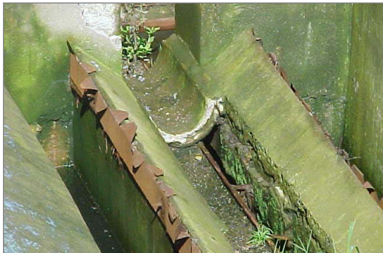
Canal de Recolección del Efluente del UASB
