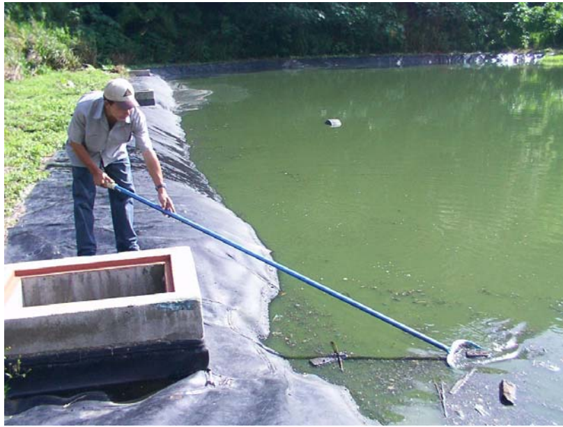
Encargado del mantenimiento limpiando las natas y material flotante cerca de la salida sur (1 er muestreo)
