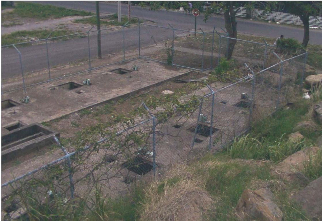
Vista General de la PTAR Santa Fe
