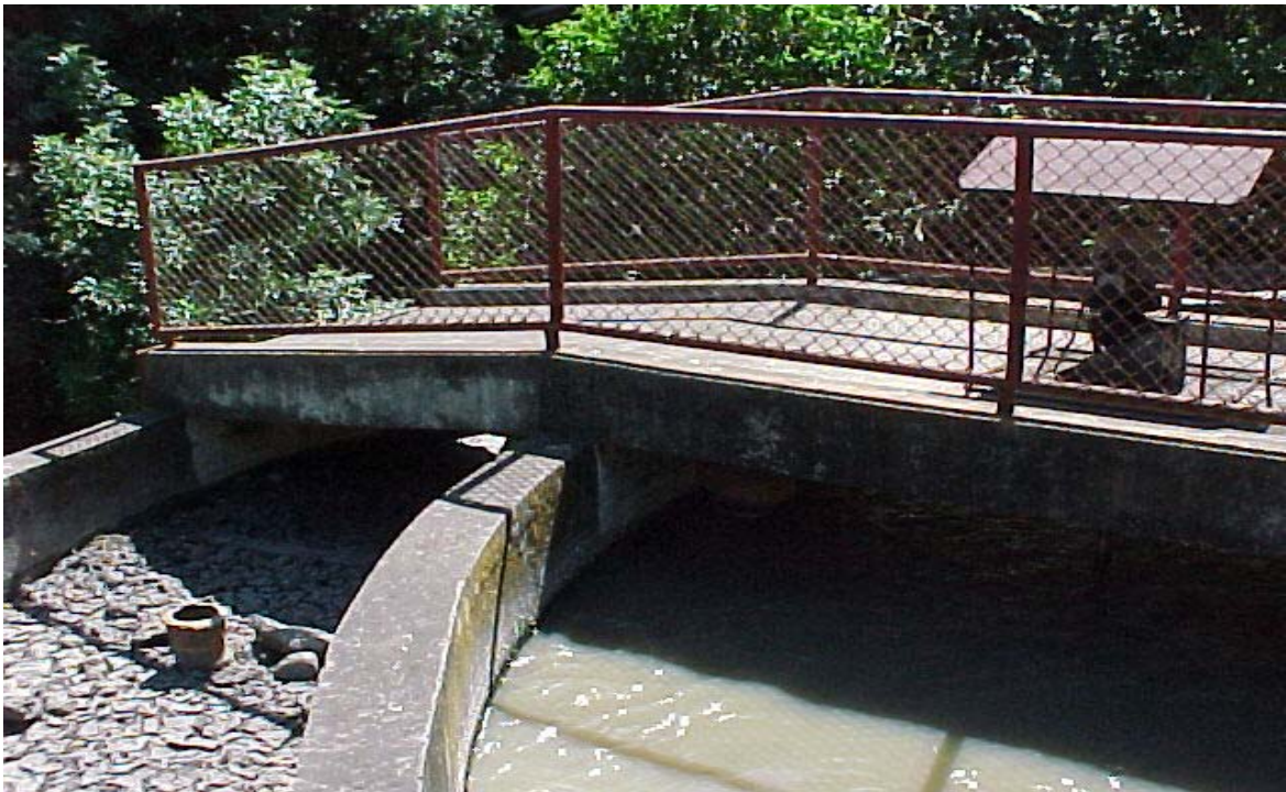
A la izquierda se observa el filtro de piedra totalmente obstruido. A la derecha el tanque de aireación. En la parte superior derecha se observa uno de los motores de la aireación mecánica.
