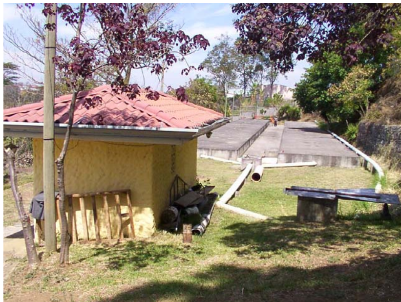
Se observa la caseta del operador y los sedimentadores primarios
