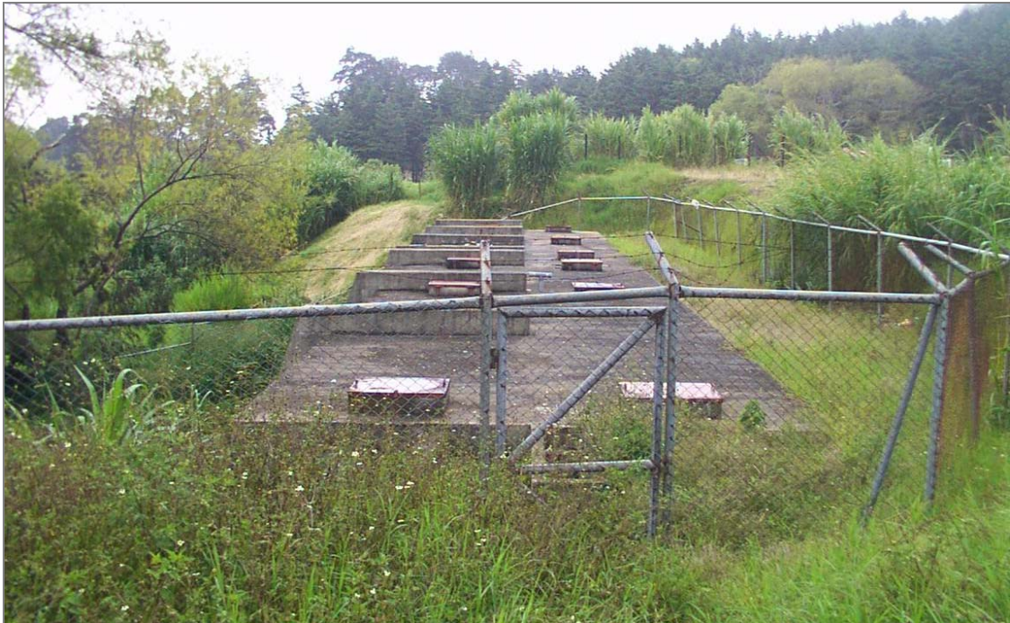
Entrada a la PTAR Entebbe
