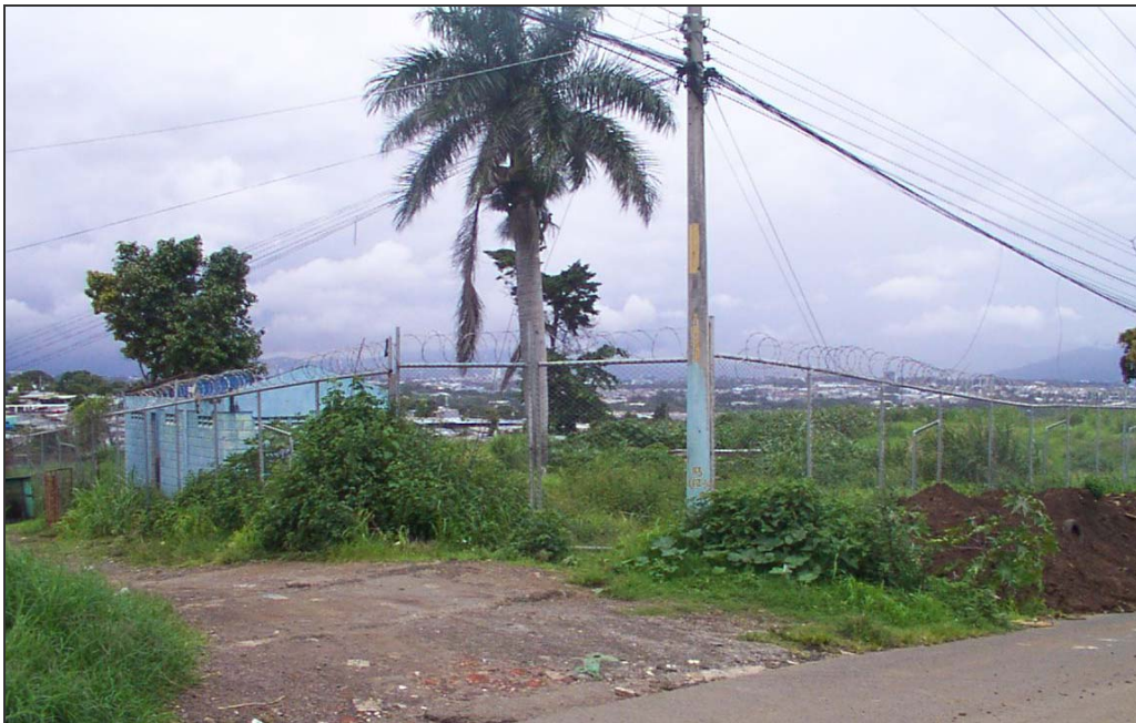
Entrada a la PTAR de la Ciudad de Heredia
