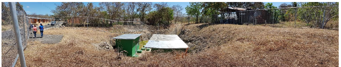
Figura 5. Vista desde nivel de calles internas del residencial.
