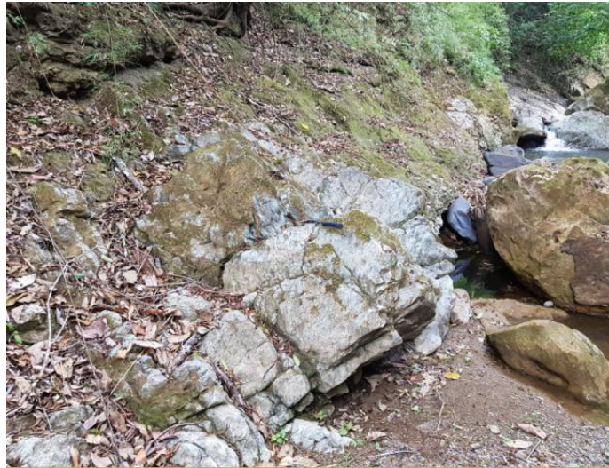
Fotografía N° 14. Inestabilidad superficial a orilla de camino.
