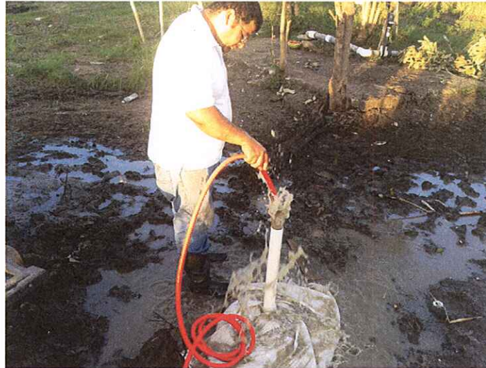
Foto N°6: Imagen del proceso de lavado del piezómetro.
