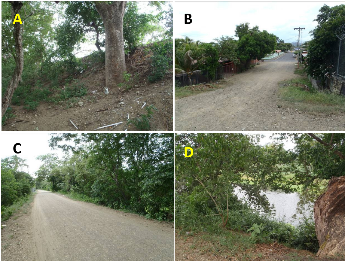
Fotografía 4. A; Vistas del dique que bordea la margen derecha del río Tempisque (367004 E - 269618 N), y B; bordea el oriente de la ciudad de Filadelfia (367086 E - 269535 N). C; Está construido sobre el aluvión, tiene paso de carretera (366936 E - 269652 N), y D; mira al río directamente (367107 E - 269554 N).
