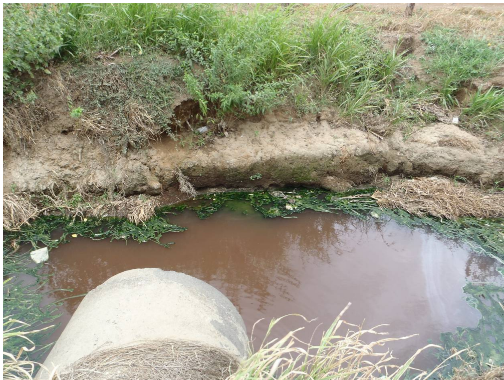
Fotografía 5. Horizontes limo-arcillosos y hasta arenosos finos, aflorantes al sur de la ciudad, en corte de canal (366590 E - 269399 N).
