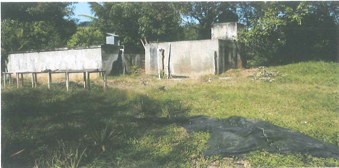
Fotografía 5. P-3, Terreno propiedad de la ASADA donde se ubican dos tanques de almacenamiento y se planea la construcción de uno nuevo (Coordenadas: 234 522 N y 446 918 E)
