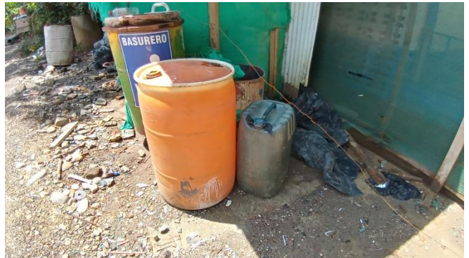
Almacenamiento de diésel sin un adecuado sistema secundario para contención de derrames.
