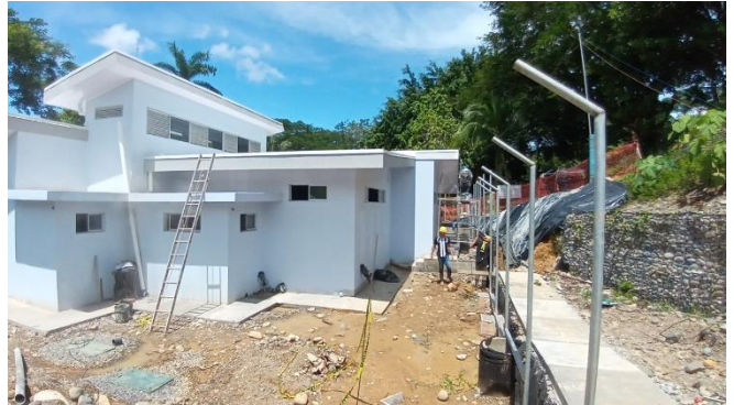
Edificio de operaciones.
