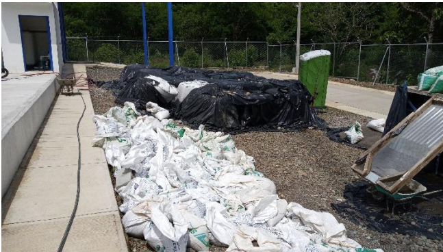
Almacenamiento de materiales para los filtros.
