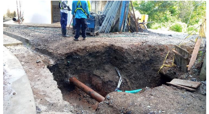
Construcción de desfogue pluvial.
