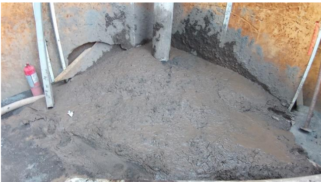
Acopio de lodos.
