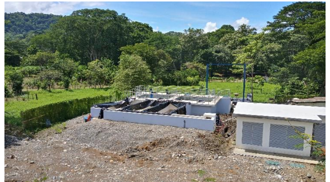
Vista de la planta y casetas de control.
