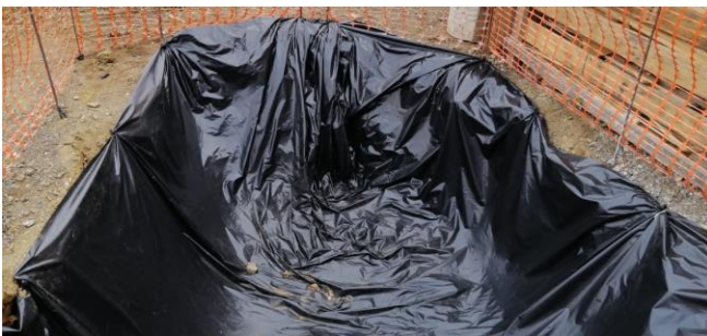
Pileta para lavado de restos de concreto.
