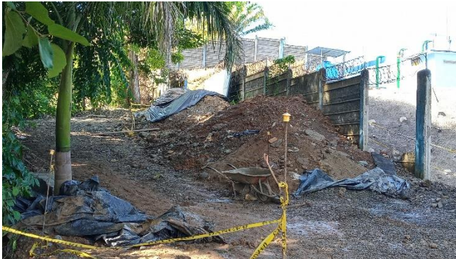
Acopio temporal de material.
