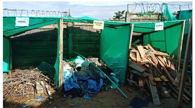
Estado del centro de acopio.
