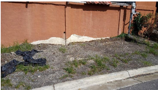
Limpieza de acopio de material.
