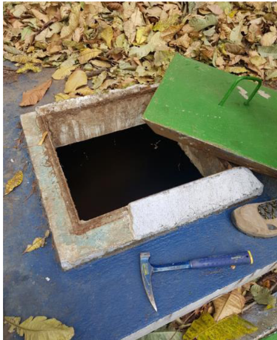
Fotografía N° 1 Captación Naciente Katadin 1.
