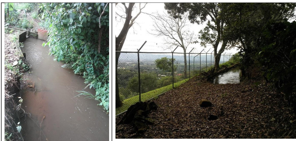
Fotografía 5: Canal de riego localizado en las cercanías de la naciente Rufino
