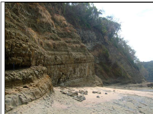
Foto 9: Acantilado de lutitas calcáreas, vista hacia el SE. Coord.: 186689N/462339E.
