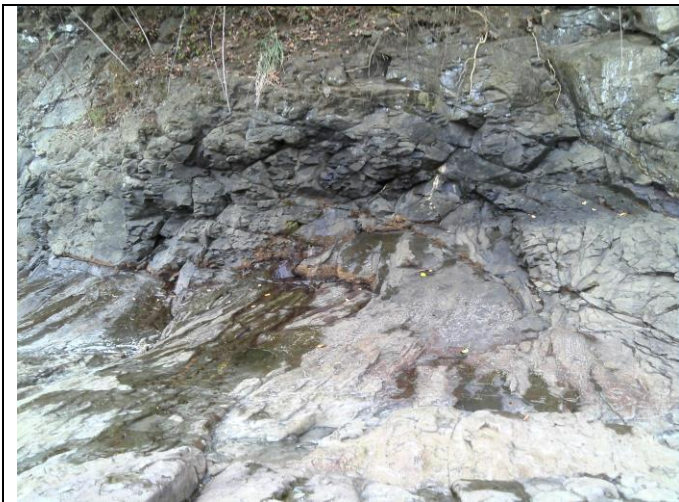
Foto 31: Afloramiento de agua en diaclasas dentro de la Unidad de Lutitas Calcáreas Caletas. Coord.: 187761N/463261E.
