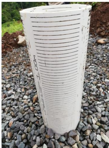
Imagen 3: Tubo ranurado en fosas.
