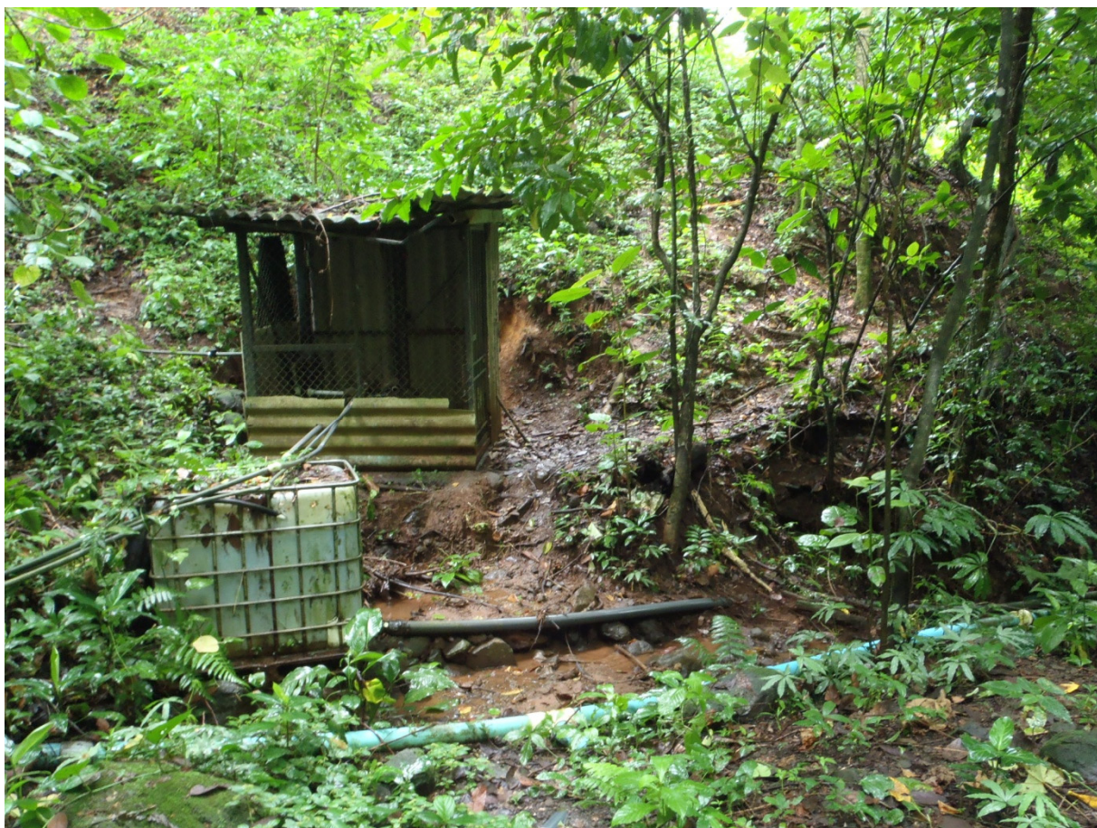
Fotografía 7. Casa de bombeo. Se ve el suelo residual de roca meteorizada, color pardo, atrás de la caseta.
