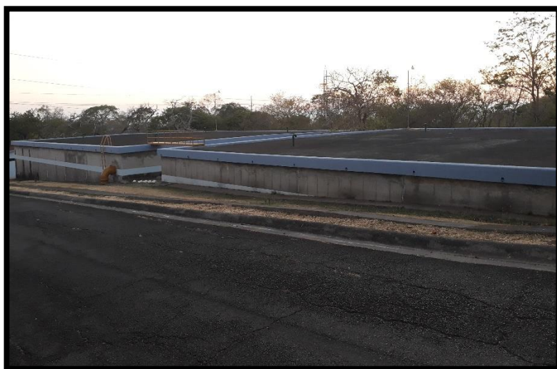
Tanques de Almacenamiento Fuente: Propia
