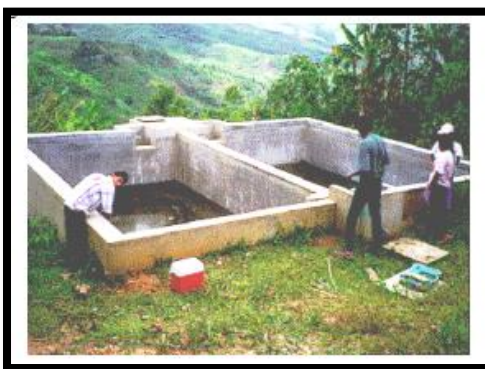
Ilustración 7 Filtro Lento de arena en zona rural
