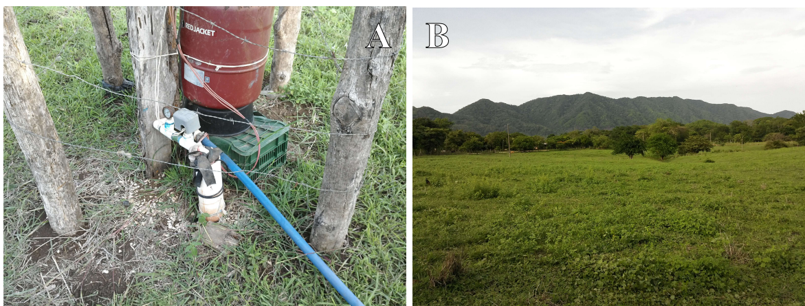
Foto 11. Pozo Perforado 1: A) Vista del Pozo & B) Vista hacia el SE desde el pozo (387516 E/ 228368 N)
