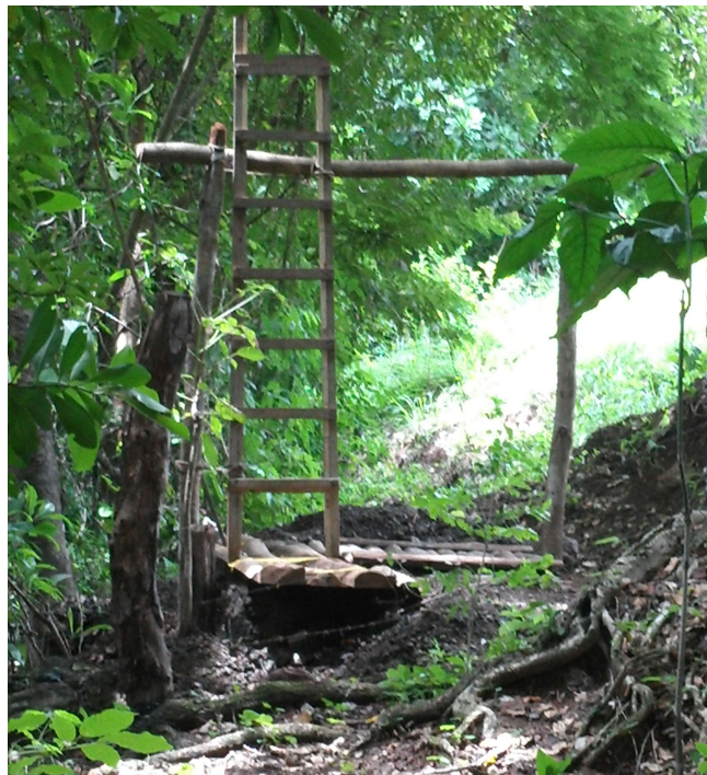
Foto 2. Pozo Artesanal en construcción (Coordenadas 388058 E / 228050 N).
