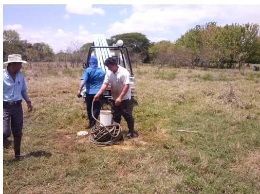
Labores previas realizadas para la instalación del equipo de bombeo.
